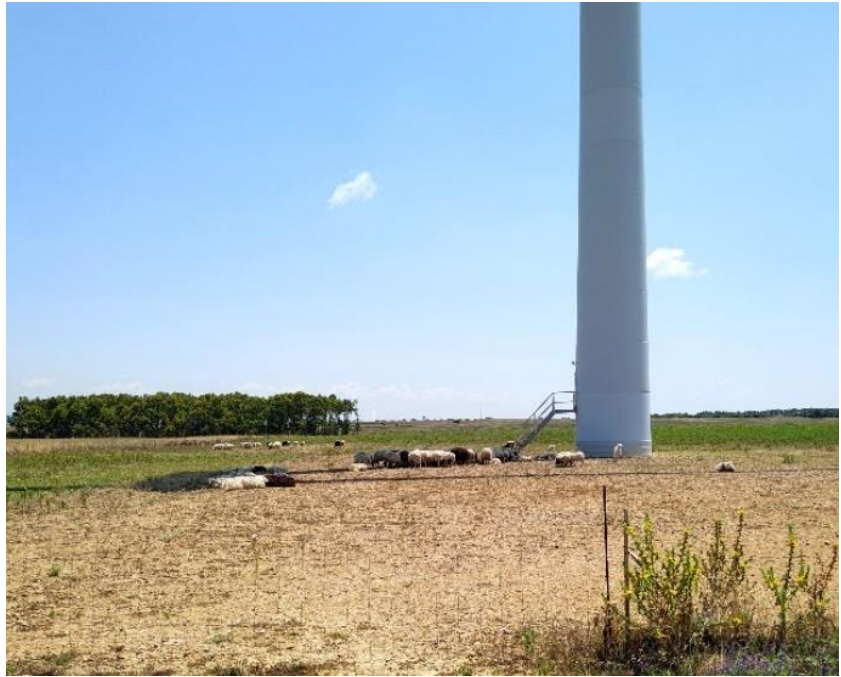
Figura 7 – Pecore all'ombra di una torre eolica in una calda giornata estiva.
