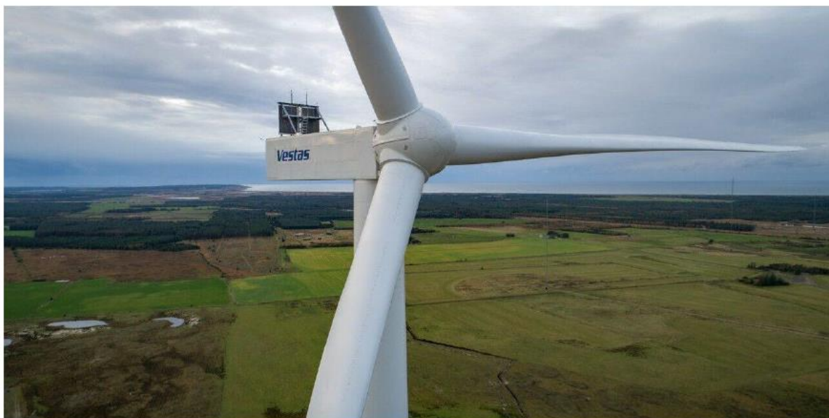
Figura 4 - Aerogeneratore Vestas Enventus 172
