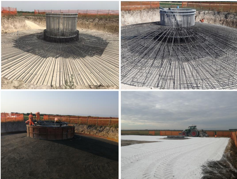
Figura 6 - Principali fasi di posa in opera plinto
