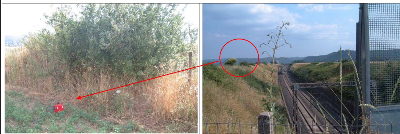
Figura 4.9-39 Punto di misura in trincea a ridosso della linea ferroviaria "Direttissima"
