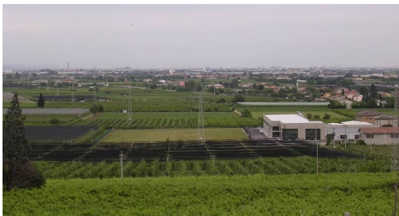
Figura 4.5/8 Visibilità delle aree infrastrutturate della pianura viste dal rilievo collinare alla base del quale verrà realizzato l'elettrodotto
