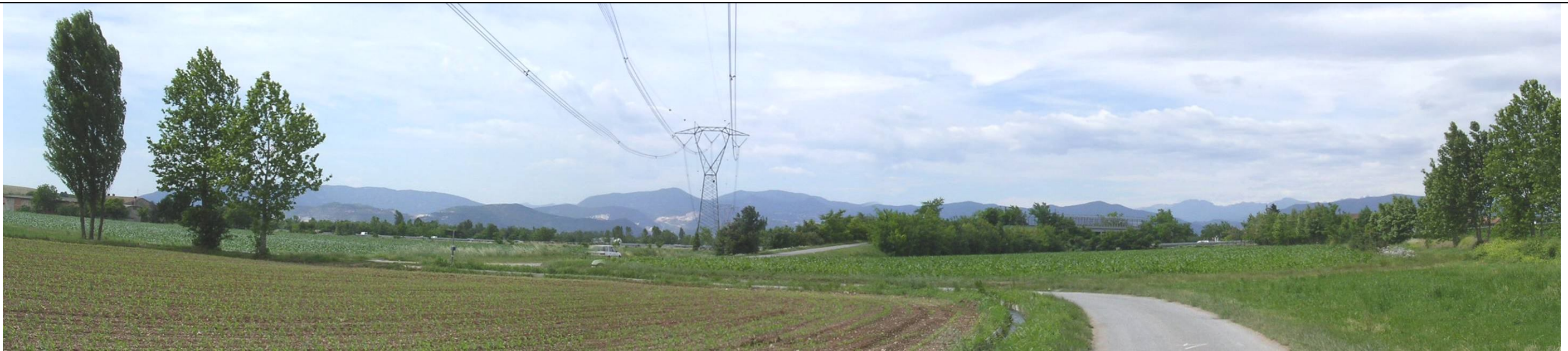
FOTO 3: Vista verso nord in corrispondenza dell'elettrodotto esistente in affiancamento a quello di progetto.
