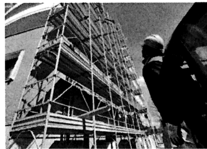
Un operaio in un cantiere edile
