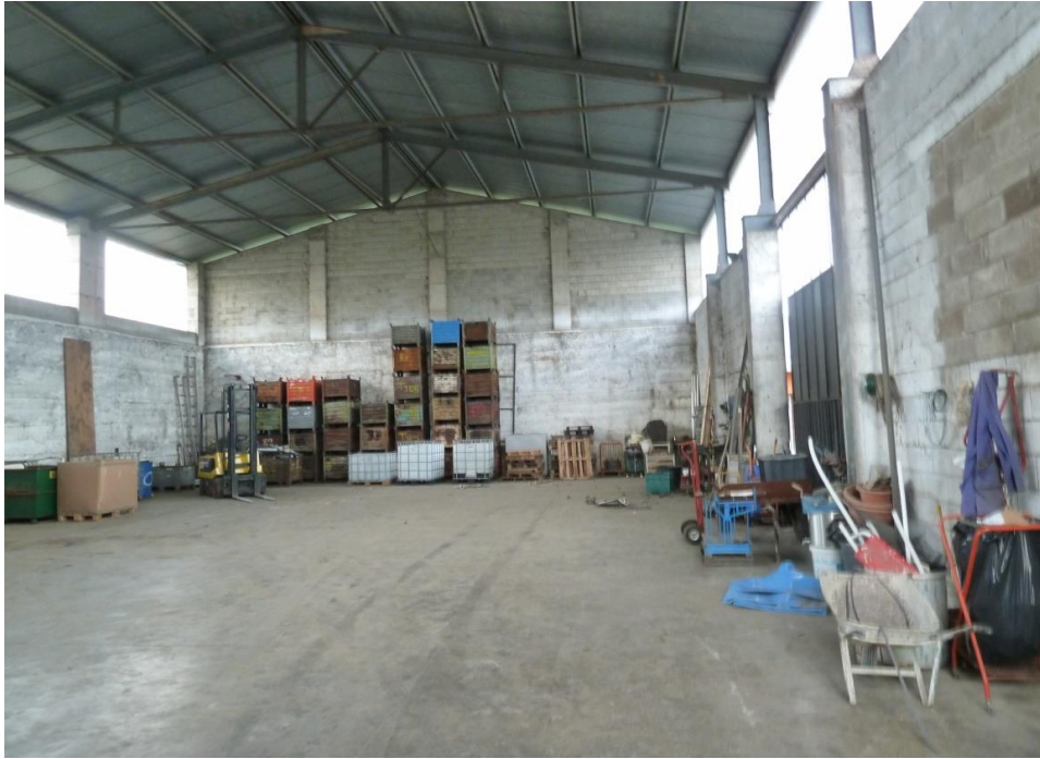
Foto 3 – Interno del capannone
