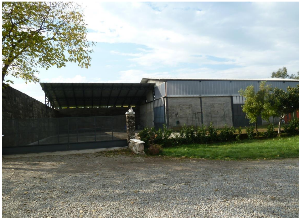
Foto 1 – Vista del capannone e dell'area esterna nel settore Nord
