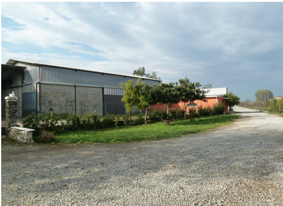
Foto 2 – Area esterna antistante il capannone nel settore Nord
