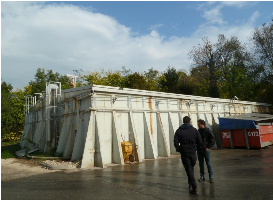
Foto 3 - Particolare del sito: vasca stoccaggio fanghi.
