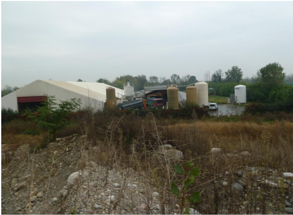
Foto 1 - Panoramica del sito, vista ovest.
