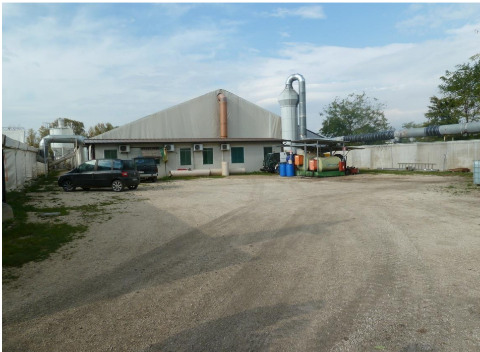
Foto 2 - Panoramica del sito, vista est.
