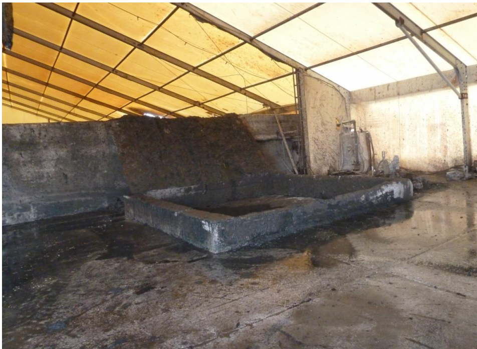
Foto 4 - Particolare dell'interno di uno dei capannoni.
