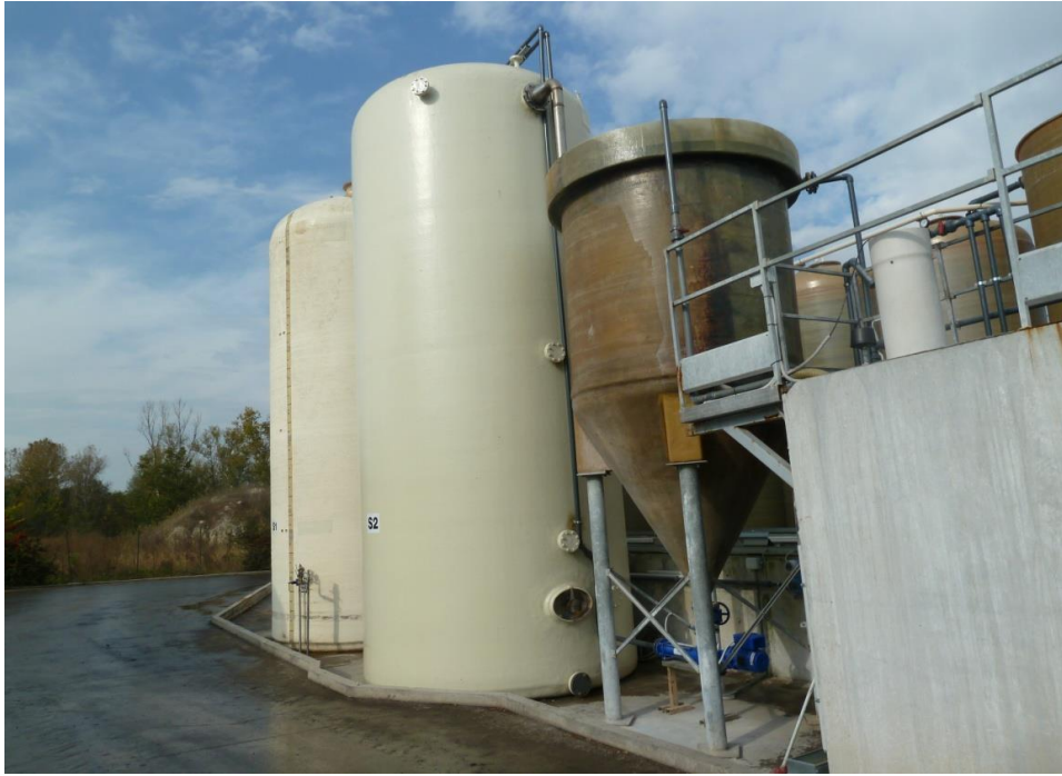
Foto 5 - Particolare del sito, vista sud.
