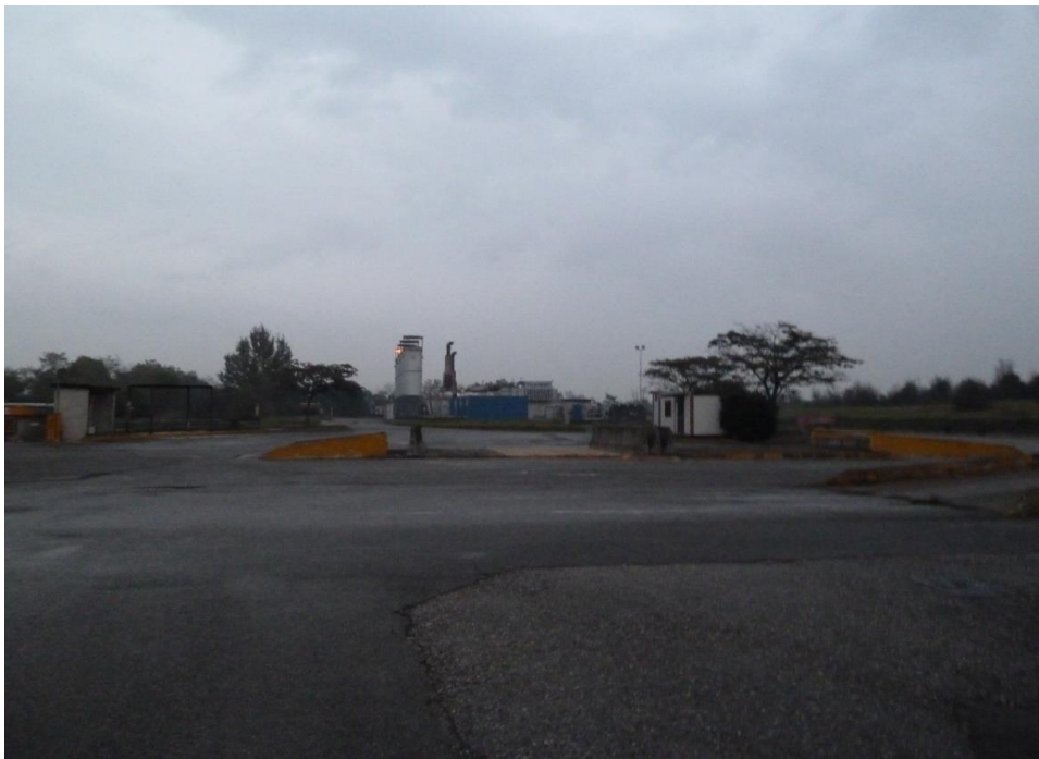
Foto 4 - Impianto di estrazione biogas discarica controllata di Calcinato, vista sud.
