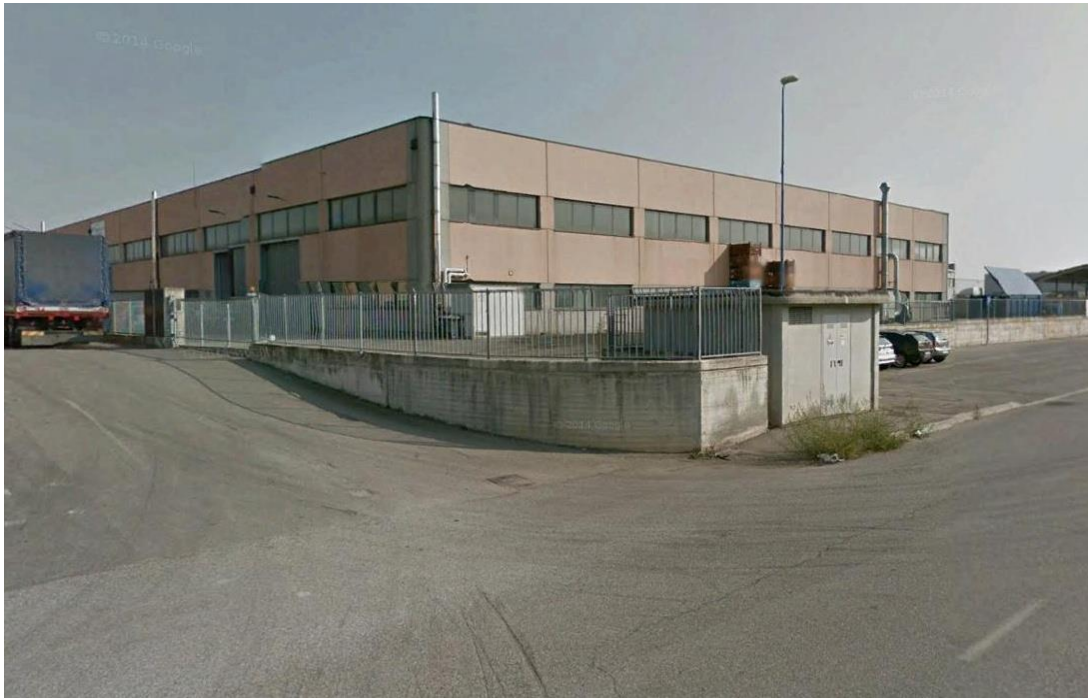
Foto 1 - Capannone est, vista sud
