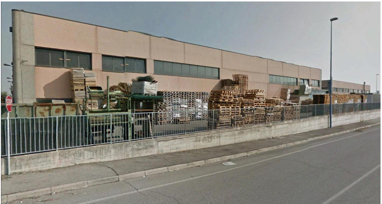
Foto 2 - Sito intero, vista sud
