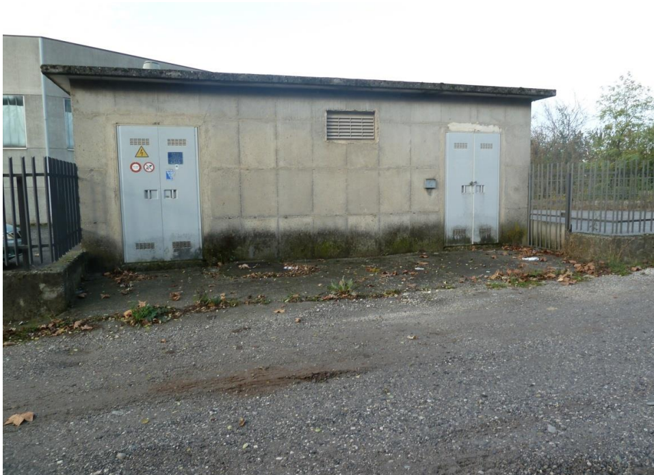
Foto 2 – Cabina elettrica ricadente nell'intersezione di foto 1
