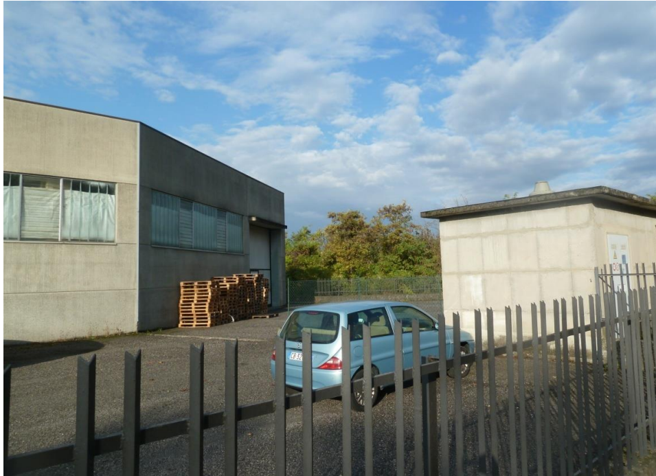
Foto 3 – Interno del piazzale dell'area produttiva interessata dalla intersezione della linea
