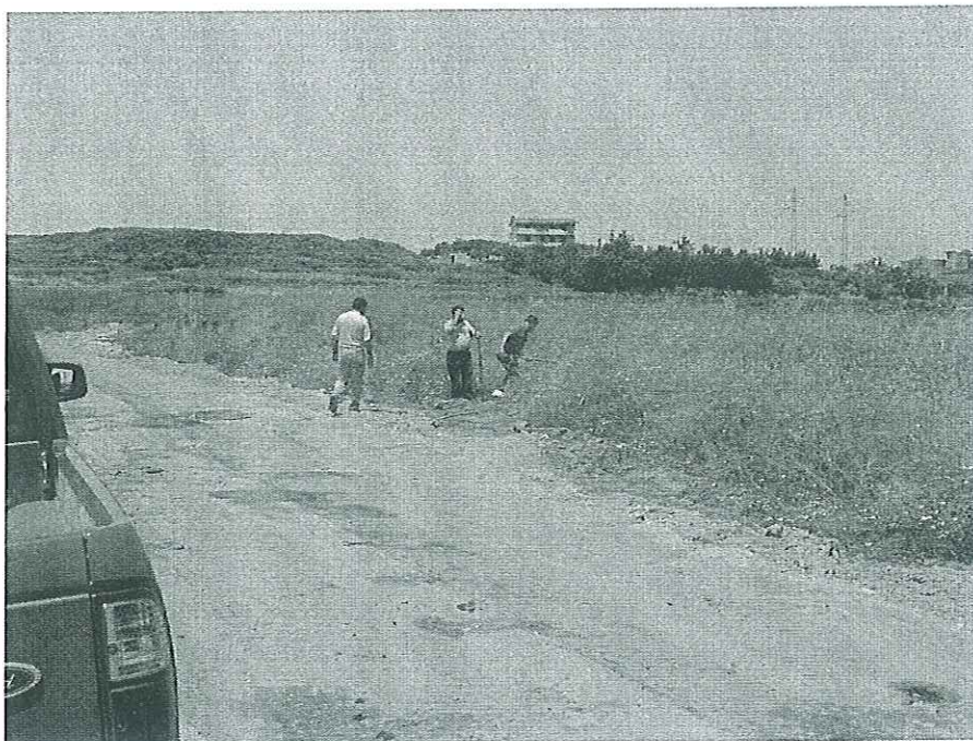
Foto n.7 – GN03 Galleria Barritteri lato Reggio Calabria - Sito RAD007 - Posa in opera campionatore
