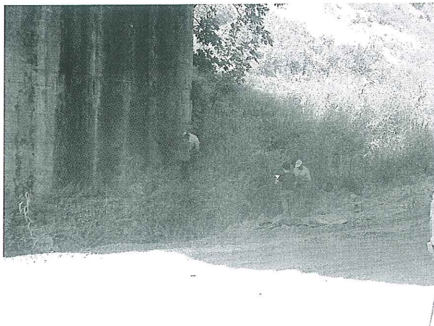
Foto n.1 – VI02 Viadotto Pantano – Sito RAD001 - Posa in opera campionatore
