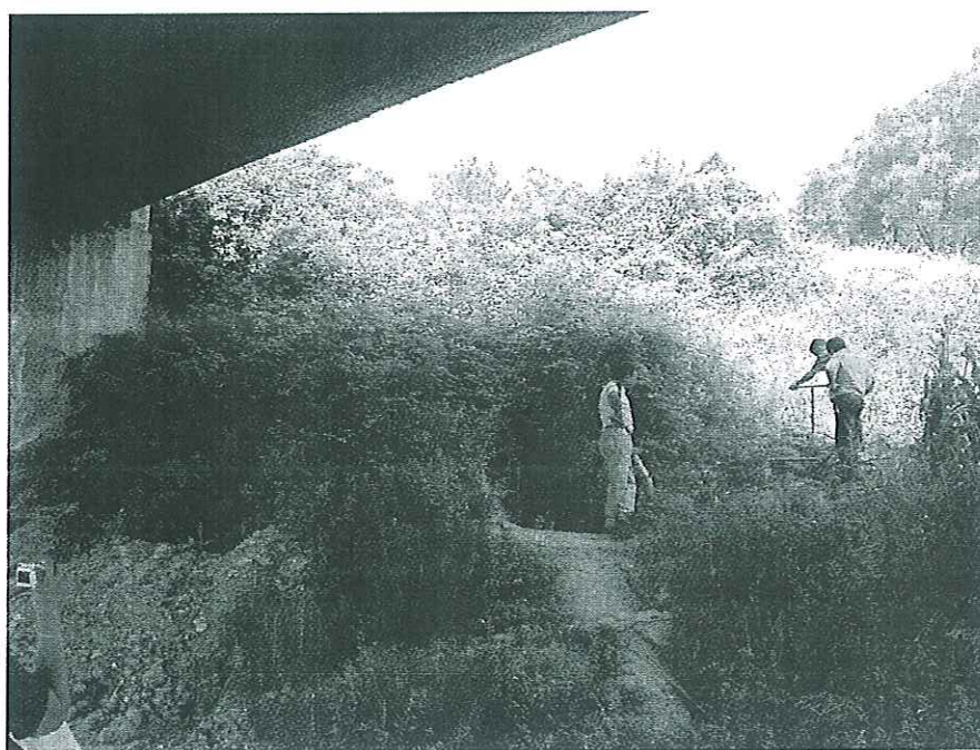
Foto n.2 – VI03 Viadotto Iropo – Sito RAD002 – Carotaggio a mano del terreno per posa in opera campionatore
