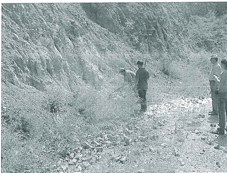
Foto n.16 – GN17-18 Galleria Brancato imbocchi lato Reggio Calabria – Sito RAD018 - Posa in opera campionatore
