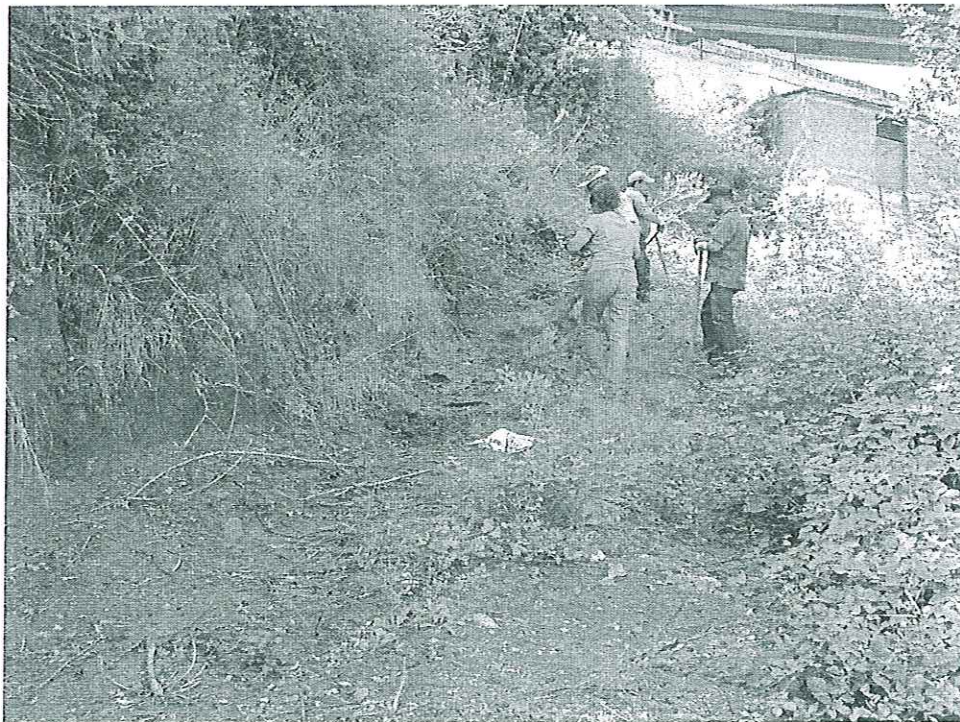
Foto n.18 – VI30-31 Viadotto D'Angelo – Sito RAD020 - Posa in opera campionatore
