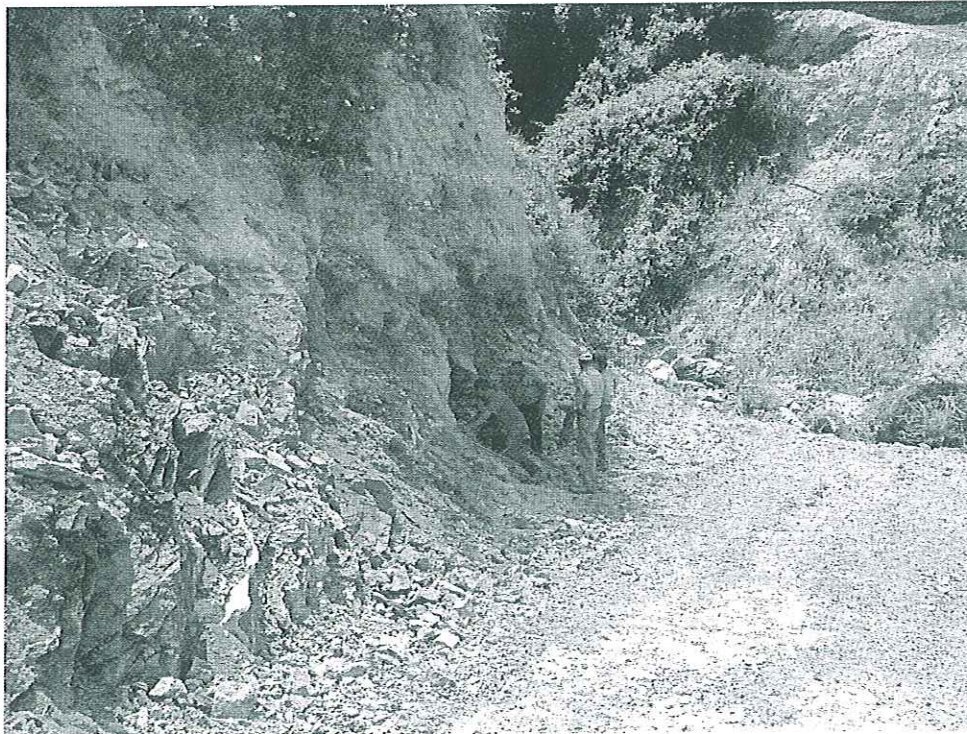
Foto n.14 – GN15-16 Galleria Muro imbocchi lato Salerno – Sito RAD015 - Scavo e Posa in opera campionatore
