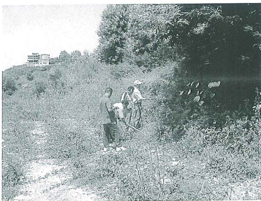
Foto n.10 – GN06-09 Galleria Bagnara imbocchi lato Reggio Calabria - Sito RAD010 – Pulizia per posa in opera campionatore
