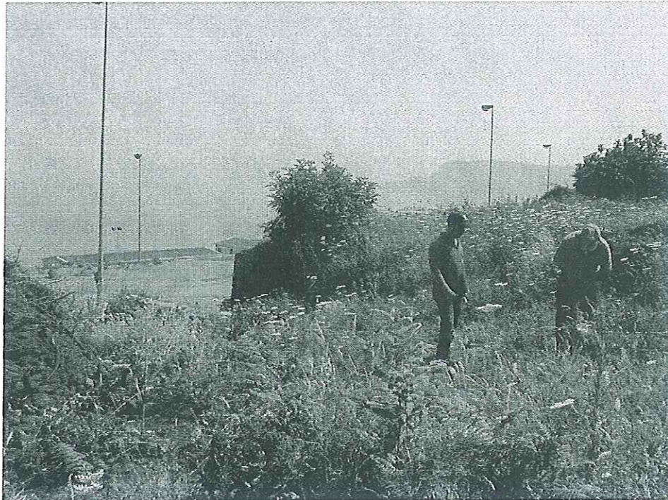
Foto n.17 – GN19-20 Galleria Costaviola Brancato imbocchi lato Reggio Calabria – Sito RAD019 - Posa in opera campionatore
