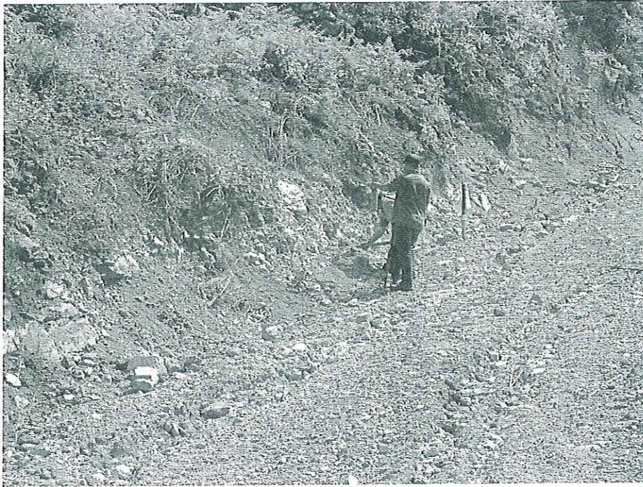
Foto n.13 – GN15-16 Galleria Muro imbocchi lato Reggio Calabria – Sito RAD016 - Scavo e Posa in opera campionatore
