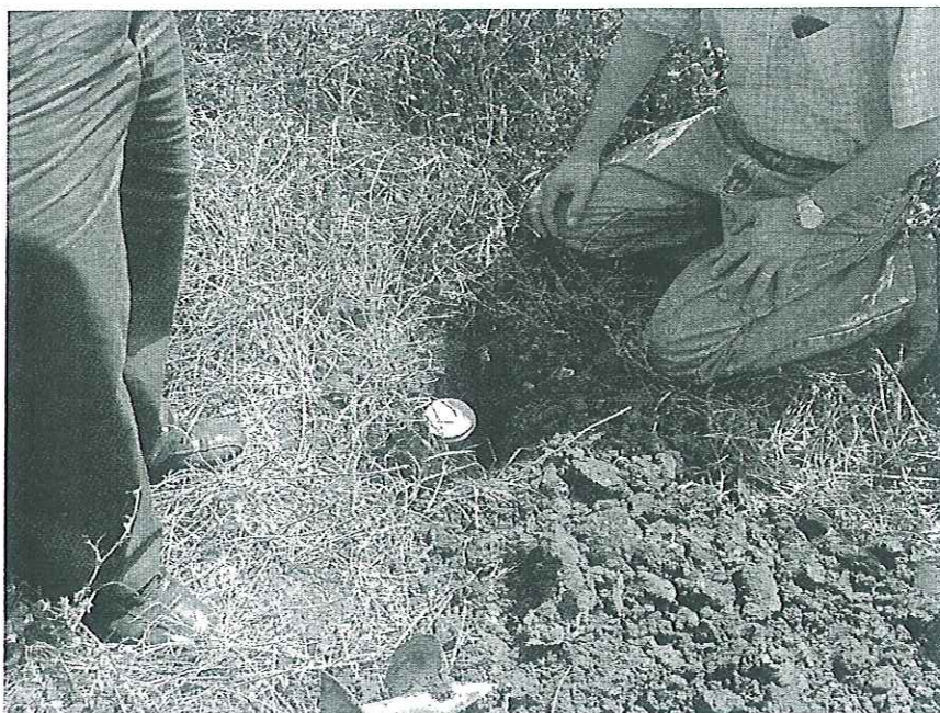
Foto n.3 – GN01 Galleria S. Filippo imbocchi lato Salerno – Sito RAD003- Posa in opera campionatore
