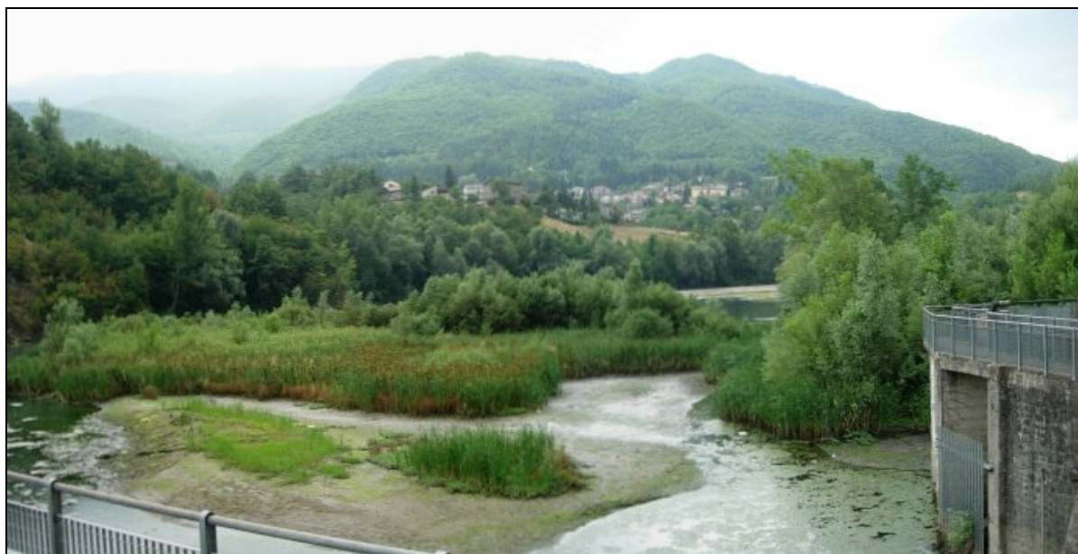
Figura 3.5 – Vista del bacino idroelettrico immediatamente a monte dello sbarramento
