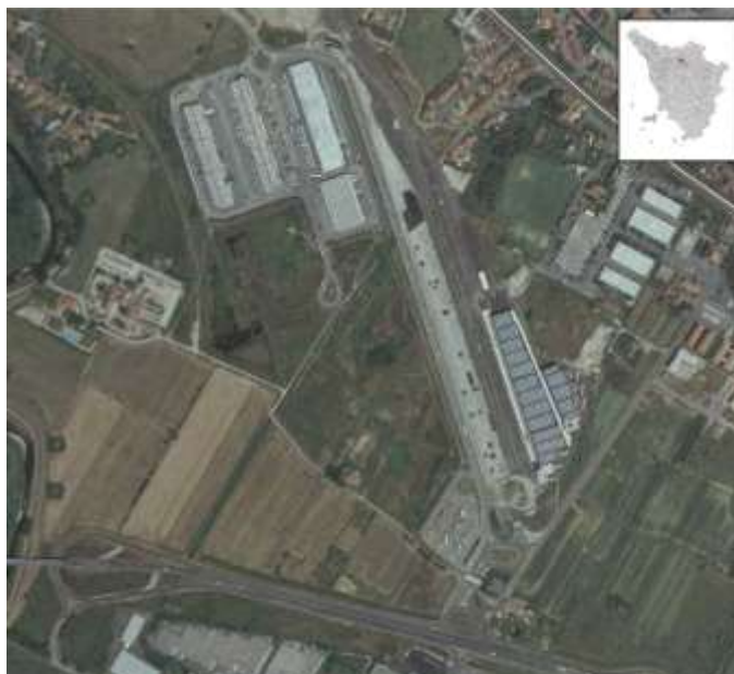
Figura 4-3 Interporto Toscana Centrale (Prato)
