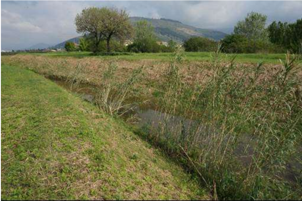
Figura 4: - Scorcio di un tratto dell'argine del torrente Marinella
