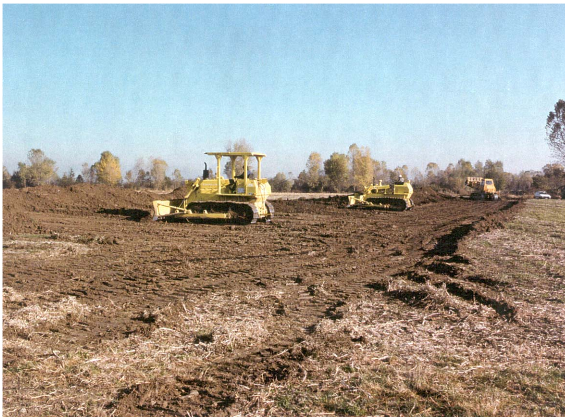
Foto 5.1/B: Apertura dell'area di passaggio
