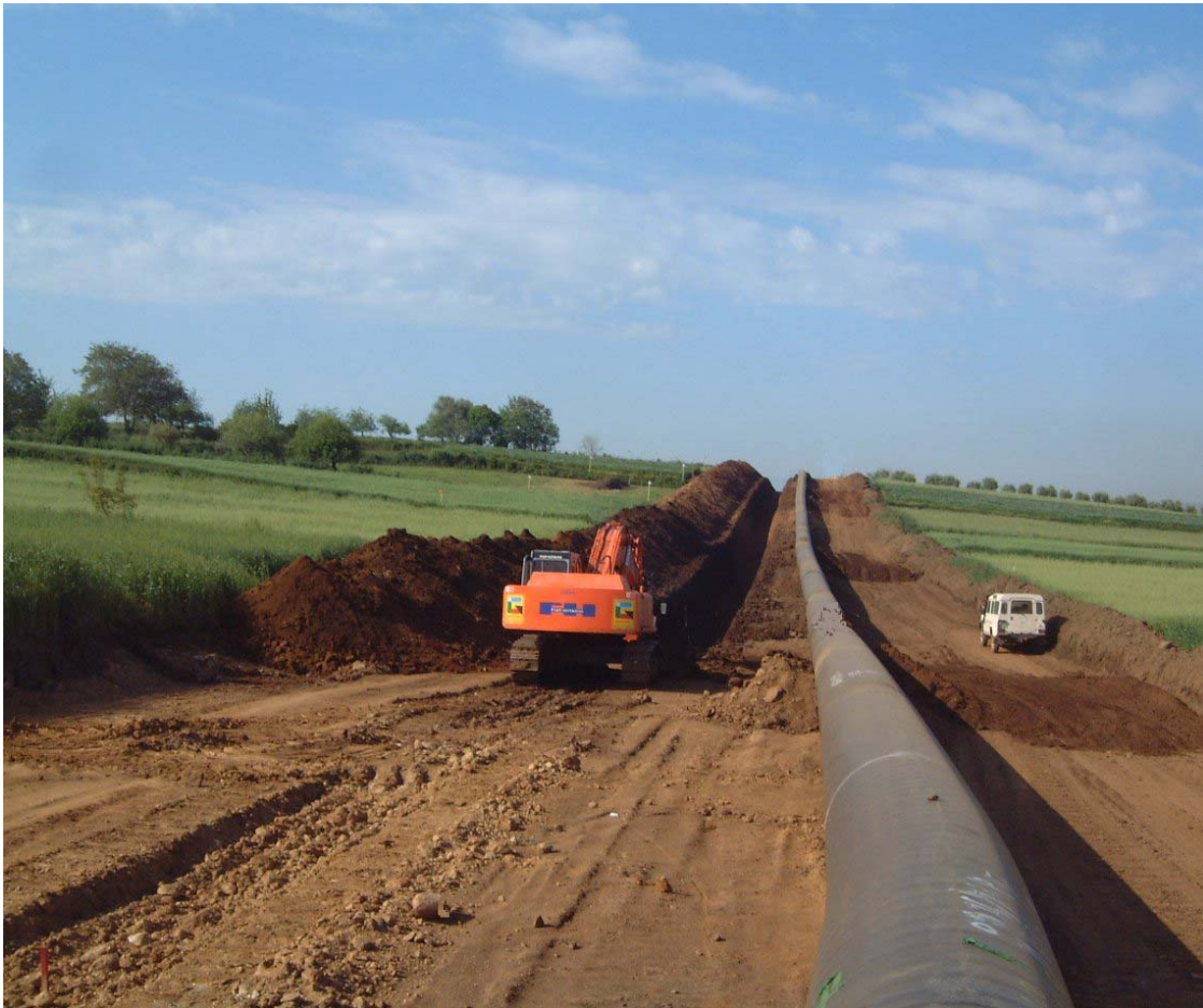
Foto 5.1/E: Scavo della trincea
