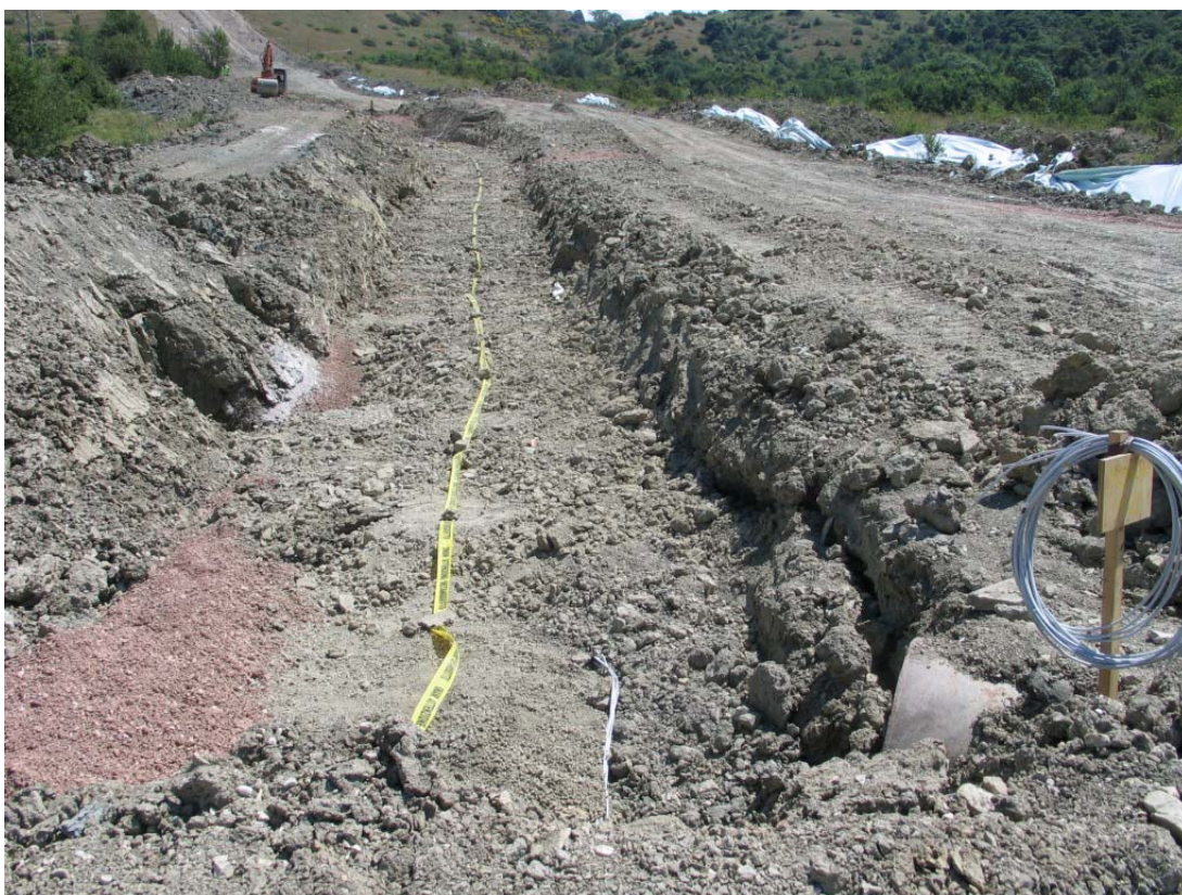
Foto 5.1/H: Rinterro della condotta
