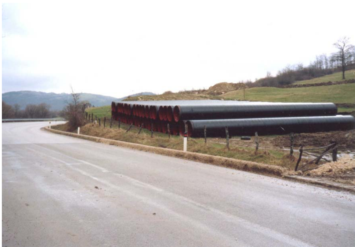
Foto 5.1/A: Piazzola di accatastamento tubazioni
