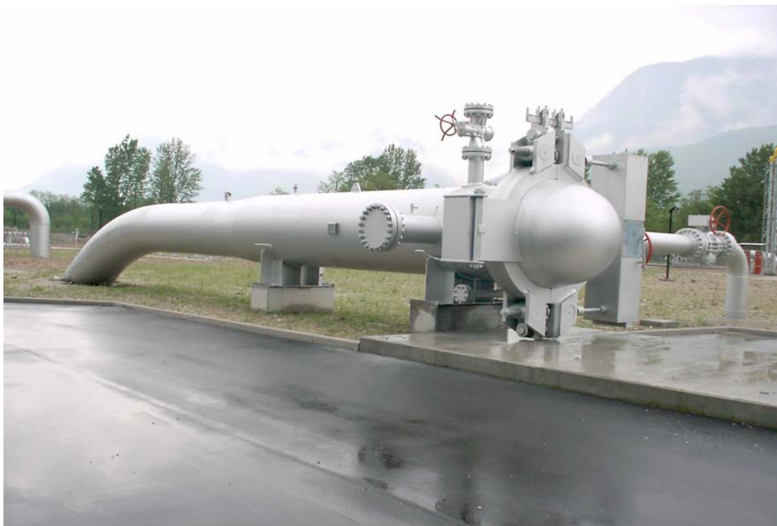
Foto 4.2/A: Punto di lancio e ricevimento pig
