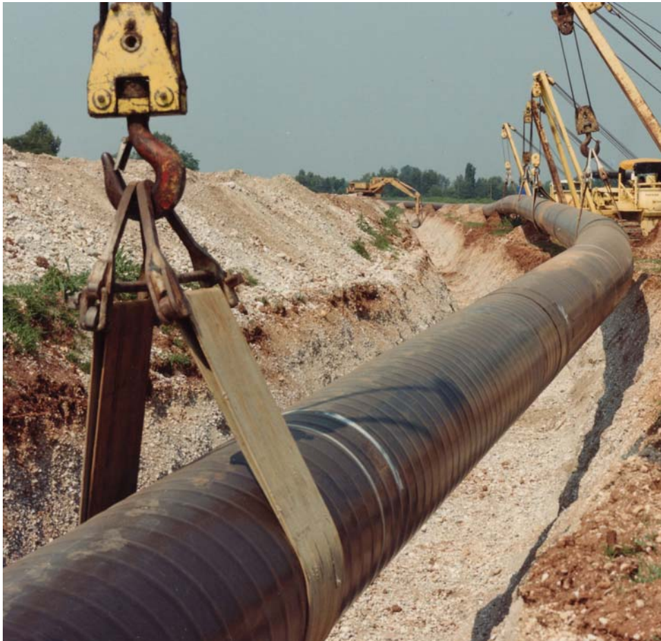
Foto 5.1/F: Posa della condotta
