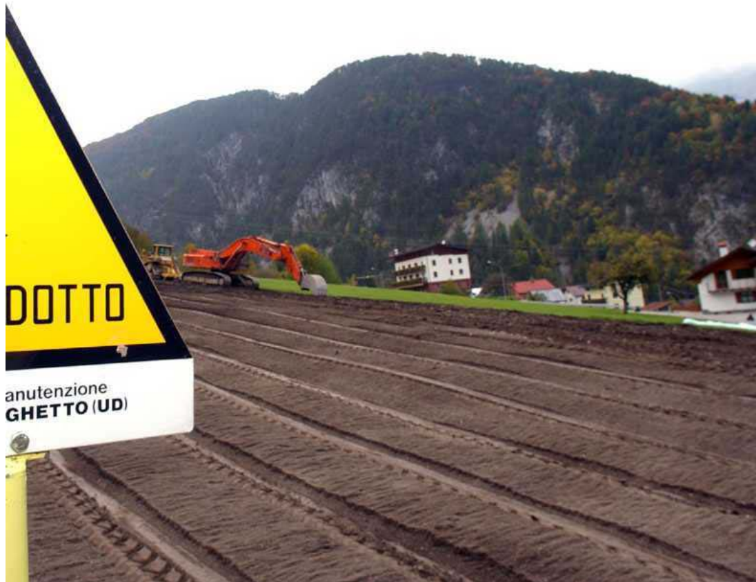
Foto 5.1/I: Ridistribuzione dello strato humico superficiale
