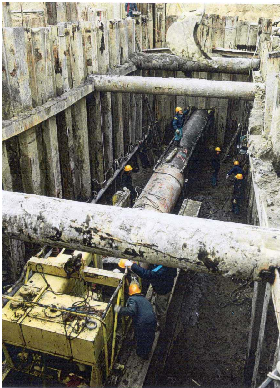
Foto 5.1/L: Trivellazione con spingitubo
