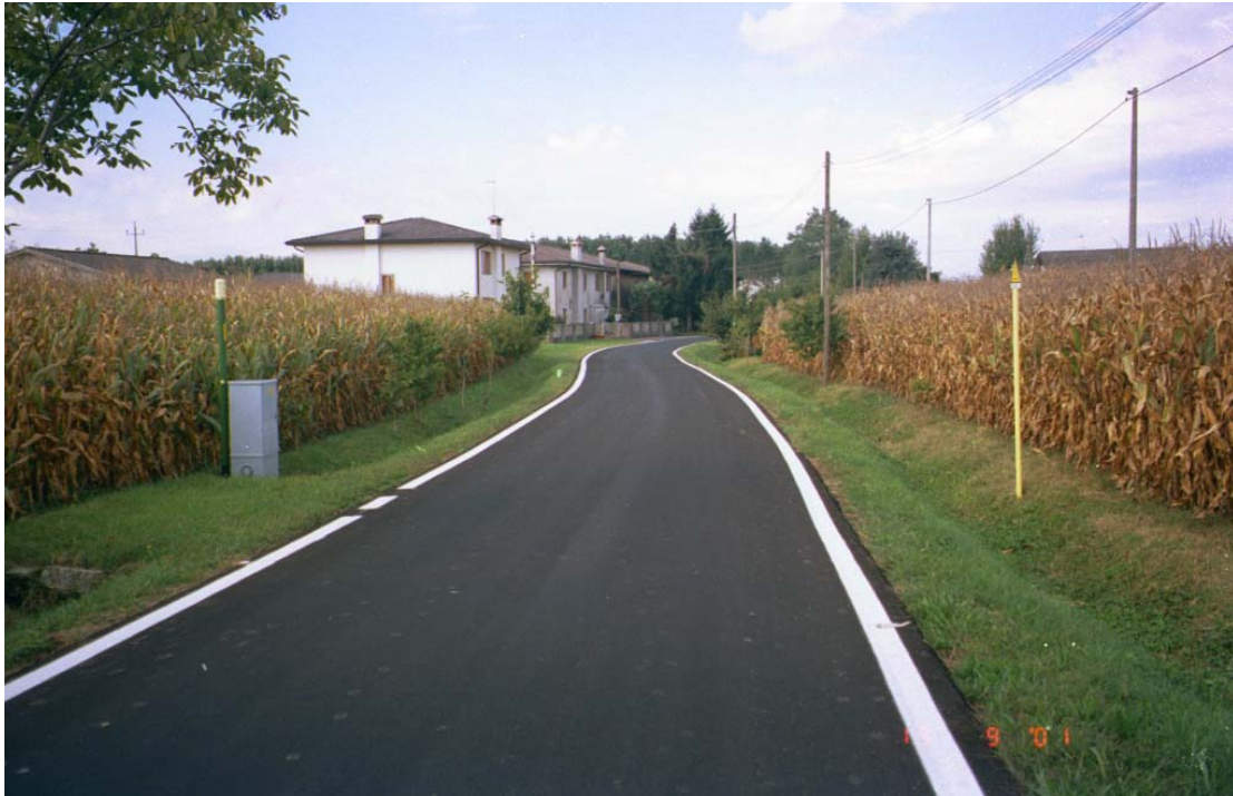
Foto 9/C: Attraversamento strada comunale
