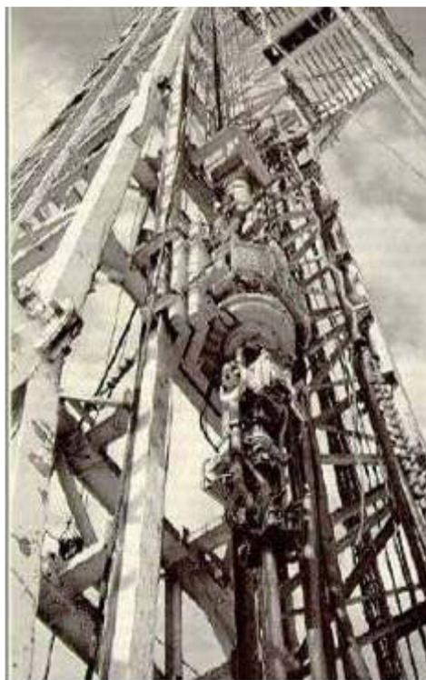
Figura 2.12: impianto di Perforazione – Top Drive System
