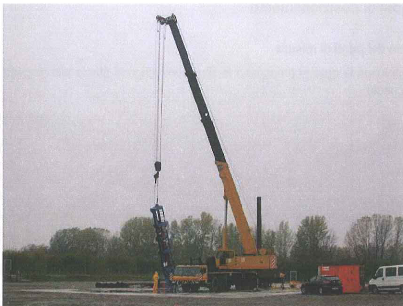
Foto 2. Vista del sistema d'infissione conductor pipe
