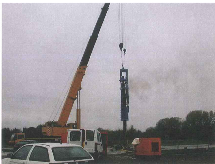
Foto 3. Vista del sistema d'infissione
