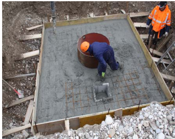
Figura 7. Realizzazione cantina. (Area pozzo Sant'Andrea 1 dirST1 – Apennine Energy S.p.A.)
