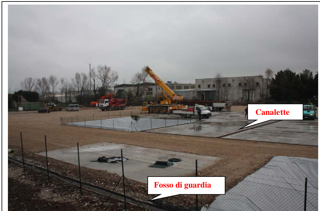
Figura 8. Solette in cemento armato e canalette di drenaggio. (Area pozzo Sant'Andrea 1 dir ST – Apennine Energy S.p.A.)
