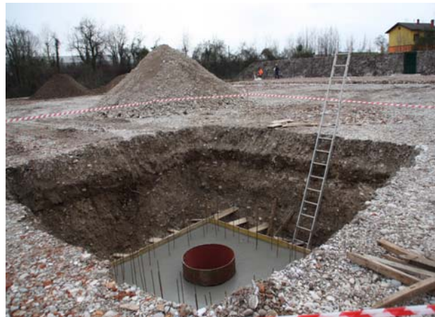
Figura 7. Realizzazione cantina. (Area pozzo Sant'Andrea 1 dirST1 – Apennine Energy S.p.A.)
