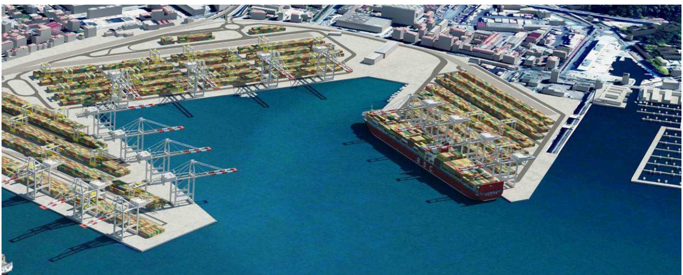
Figura 2.38 – Realizzazione terzo molo in zona Fossamastra – simulazione virtuale
