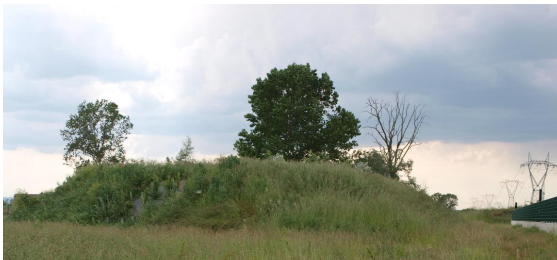
Figura 1 – Mancati attecchimenti di Farnia presso la SE di Chignolo Po (PV)
