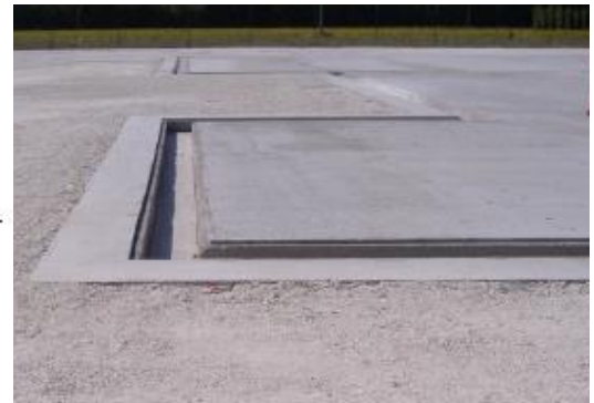
Figura 4.h: Dettaglio Canalette
