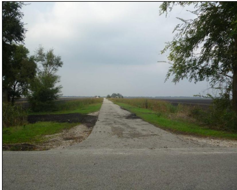
Figura 4.a: Strada di Accesso alla Postazione
