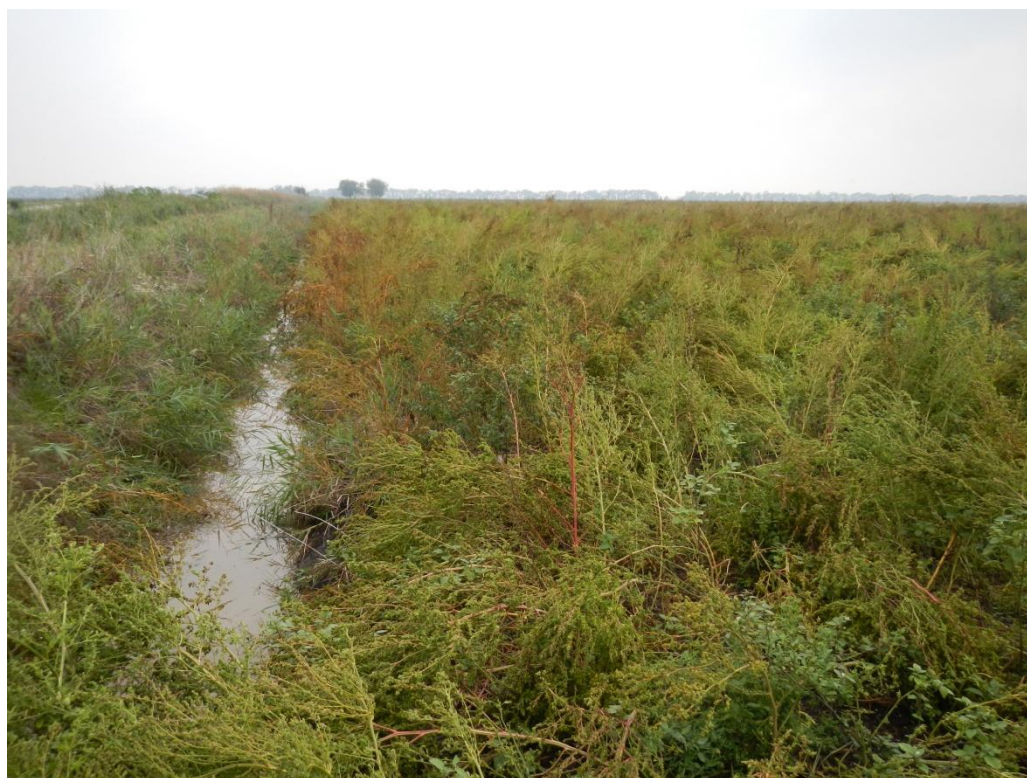
Figura 6.c: Canale Minore posto al Confine Est dell'Area di Cantiere (Sopralluogo Ottobre 2013)
