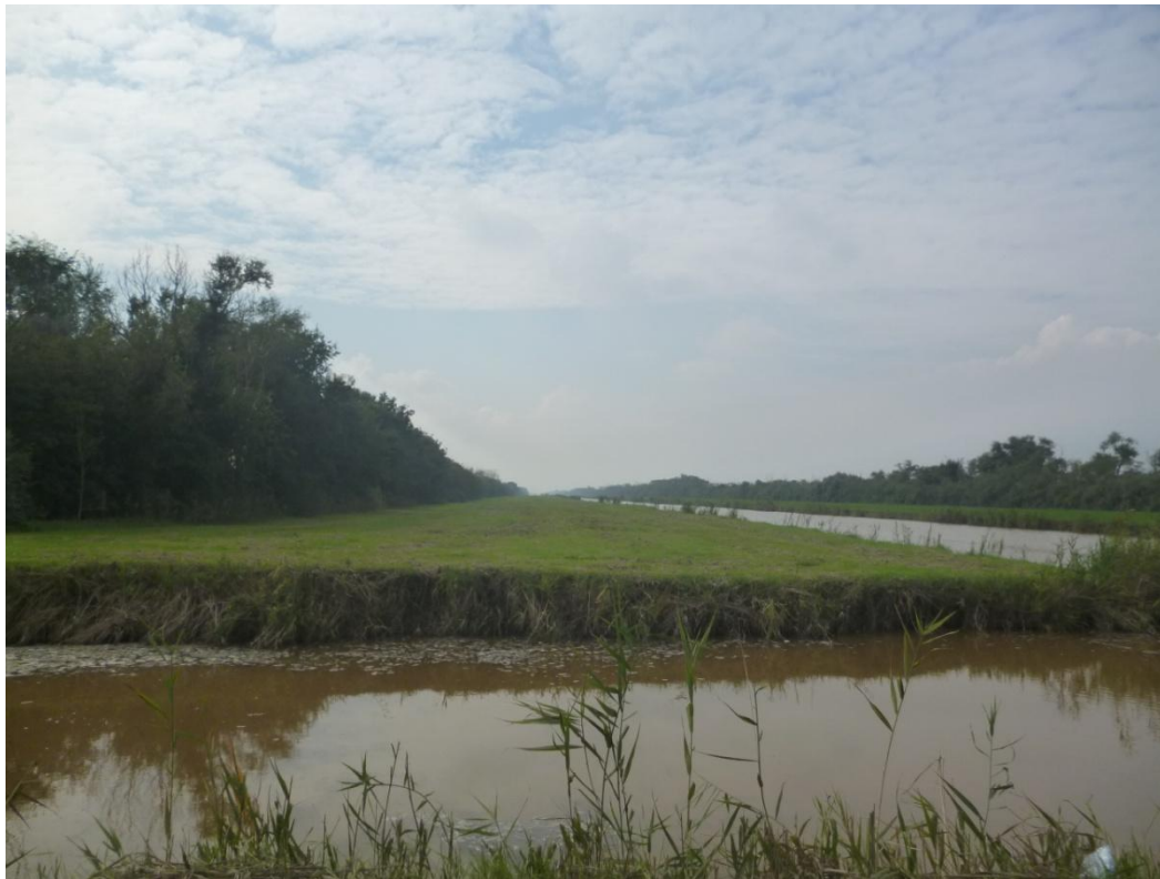
Figura 6.b: Confluenza tra il Canale Secondario Specchio e il Canale Mezzano (Sopralluogo Ottobre 2013)
