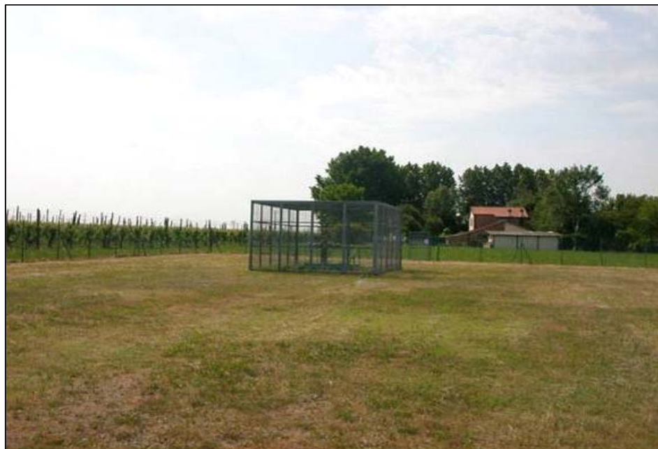
Figura 3.11.1: Tipico gabbia metallica a protezione della testa pozzo
