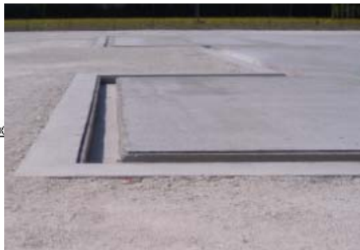
Figura 3.8.8 - canalette in cls armato per la raccolta delle acque meteoriche
