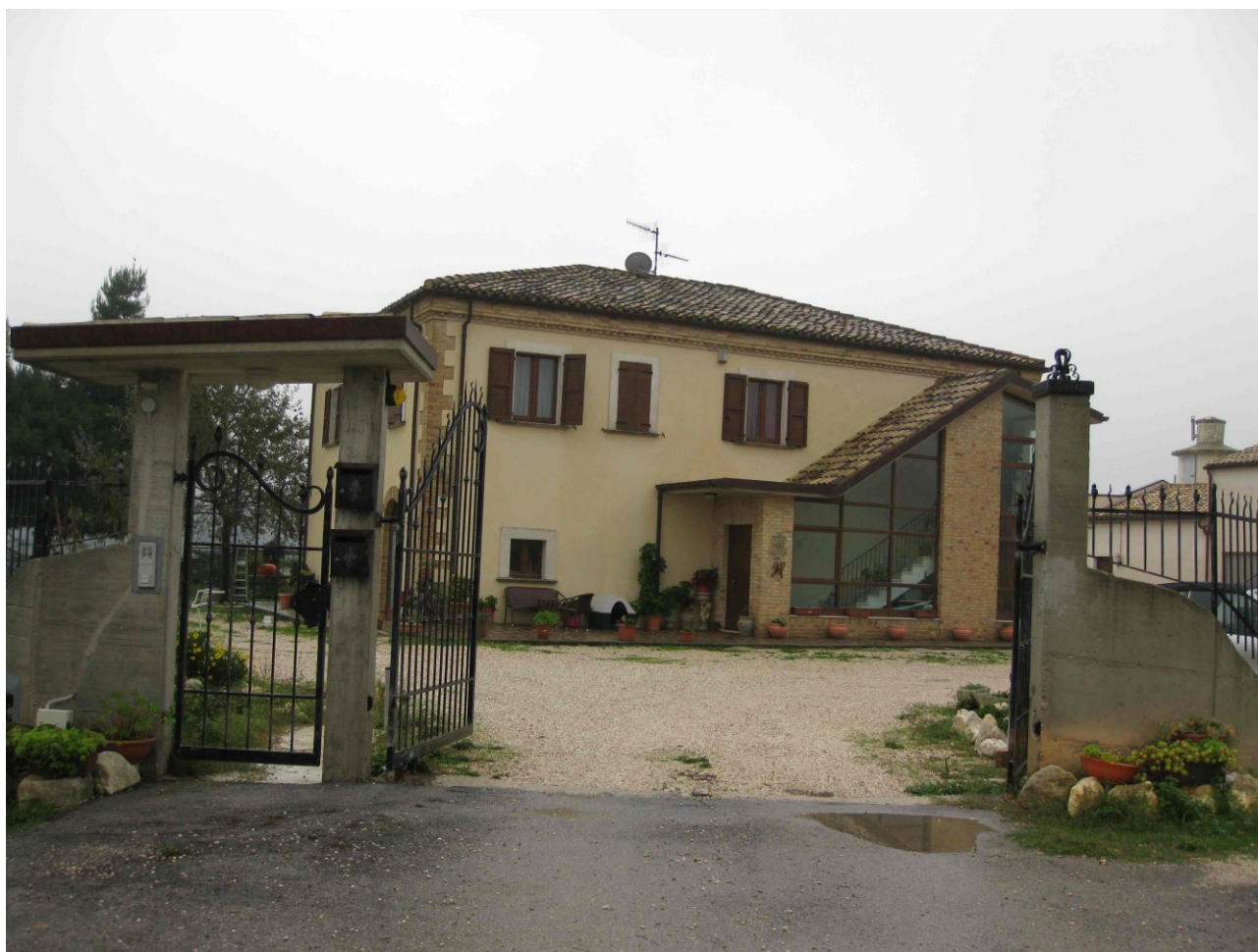
Figura 7 – Ingresso dell'edificio in contrada Colli
