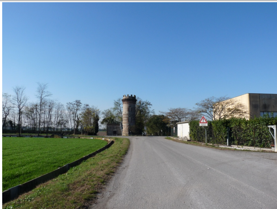
STATO DI FATTO – RILIEVO FOTOGRAFICO
