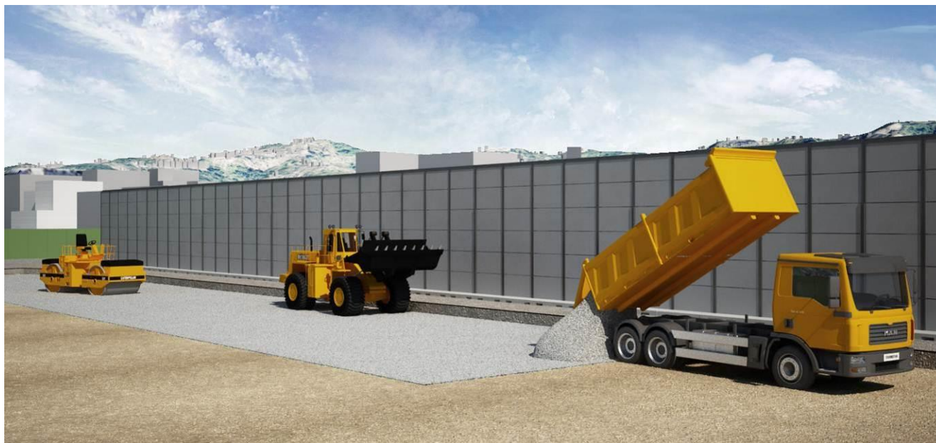
Figura 3-145 – Barriera antirumore di tipo mobile
