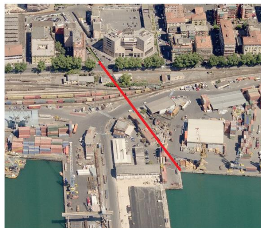
Figura 3-131: T. Cappelletto, tratto critico tra Viale San Bartolomeo fino allo sbocco in mare
