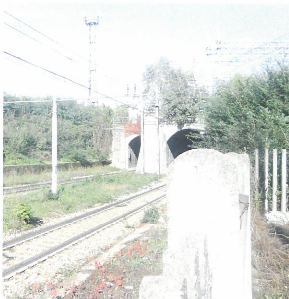
Gallerie naturali esistenti da sfruttare come passaggio per accedere all'area interclusa
