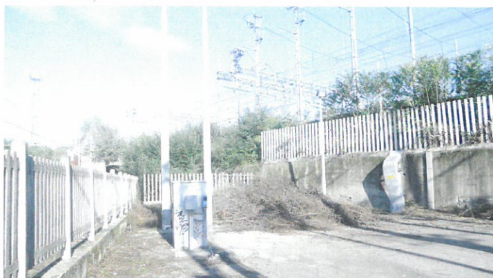
Area di lavoro per costruzione GA01A
