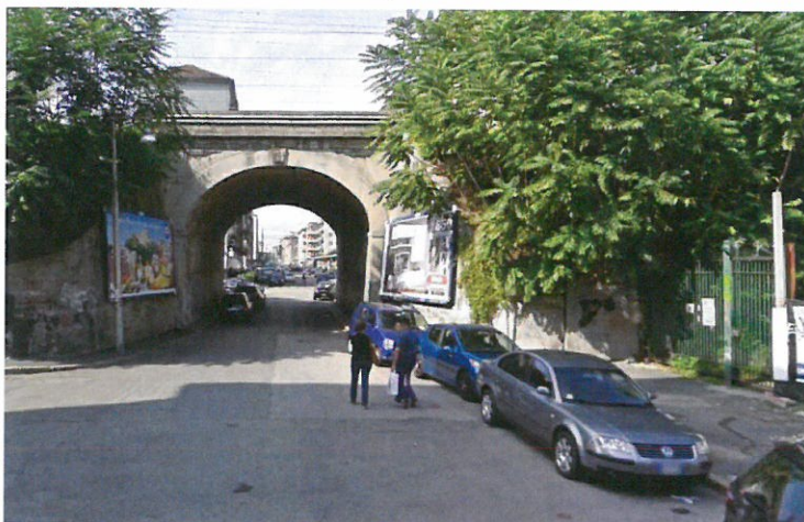
Ponte esistente su via Amadeo
