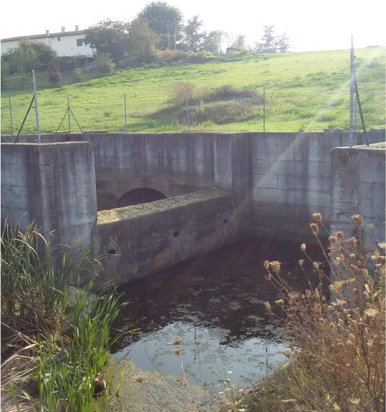
Fotografia 1: Ingresso tubo  $\phi 1500\text{mm}$  nella vasca di dissipazione esistente
