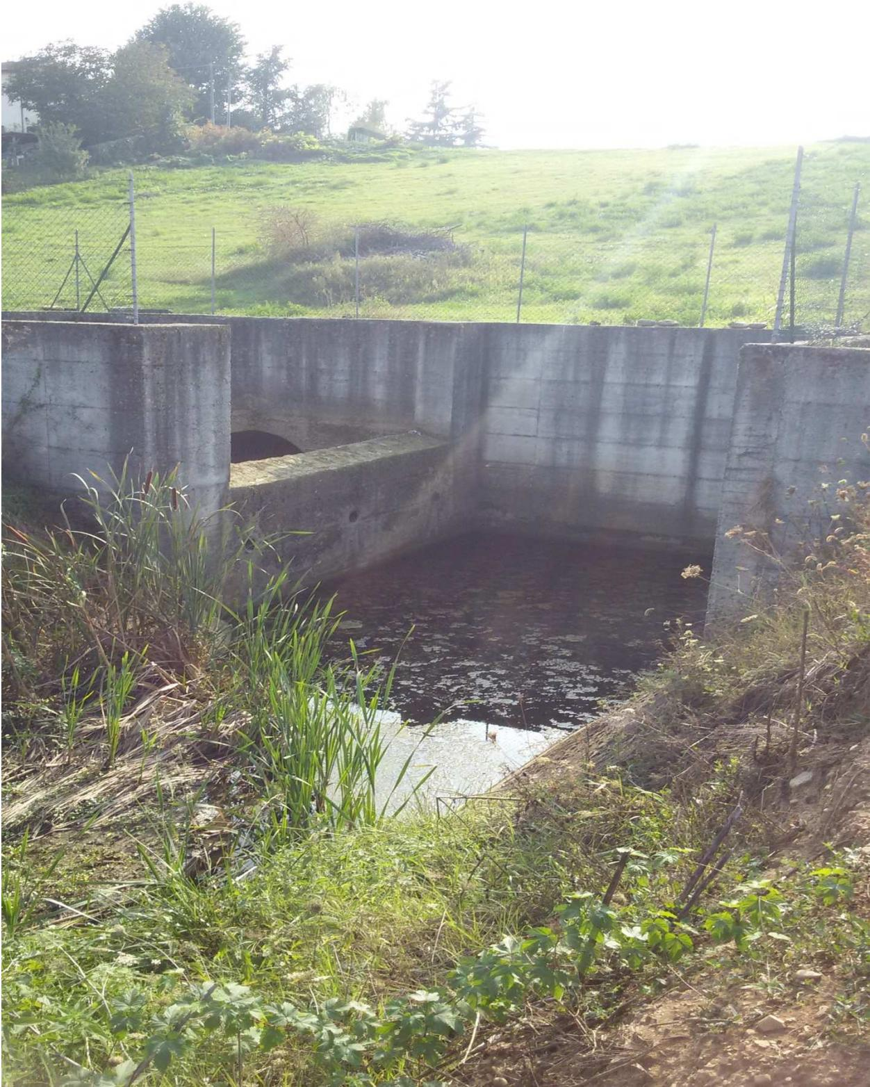
Fotografia 2: Tratto iniziale del canale a sezione trapezia
