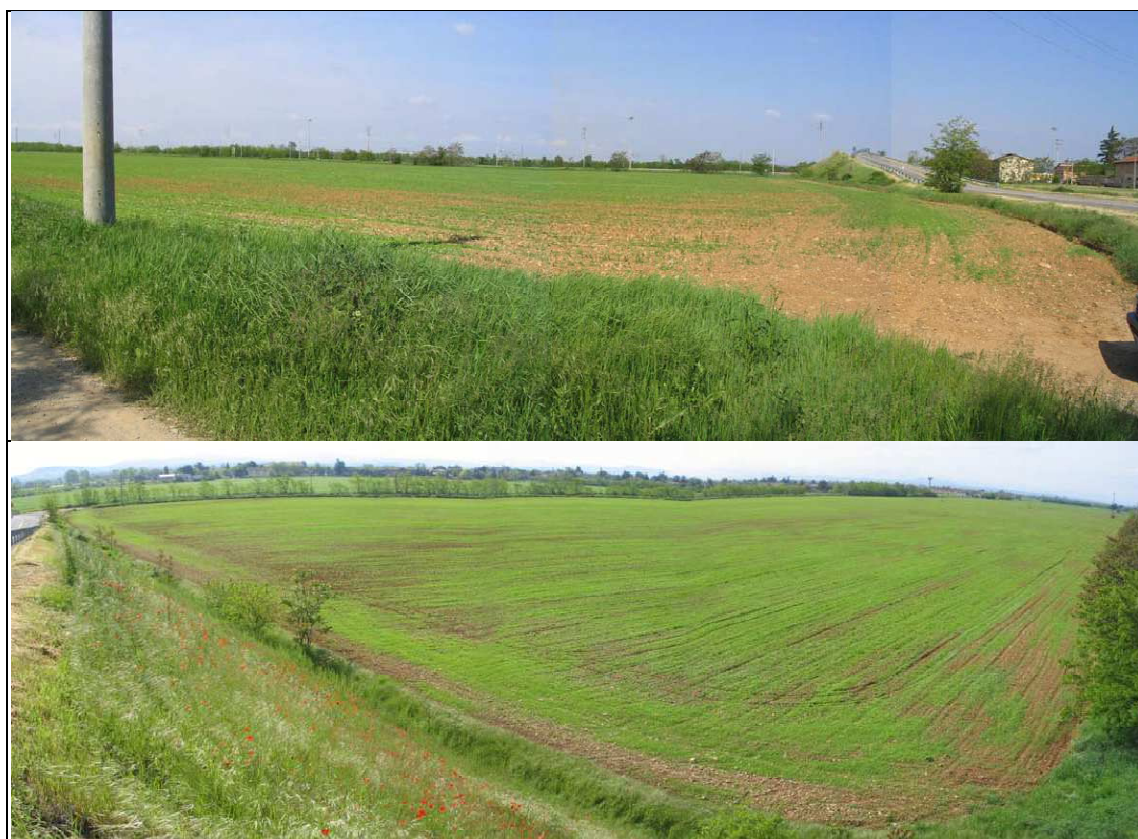
Figura 3.1 – Area di cantiere
