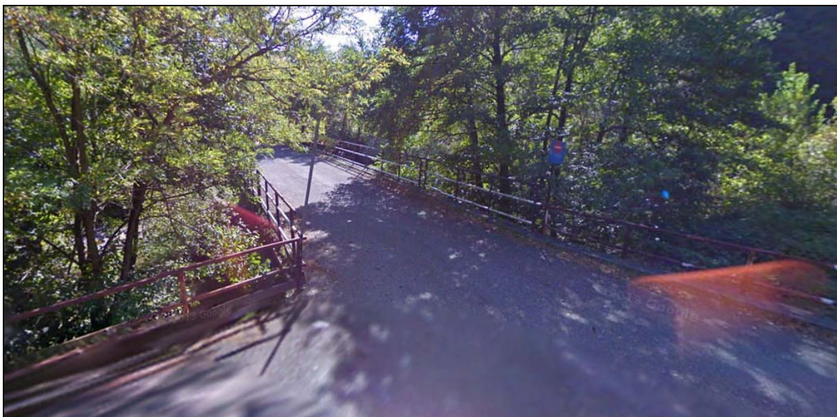
Fotografia n. 1: ponte di accesso all'area CSP3, esistente.
