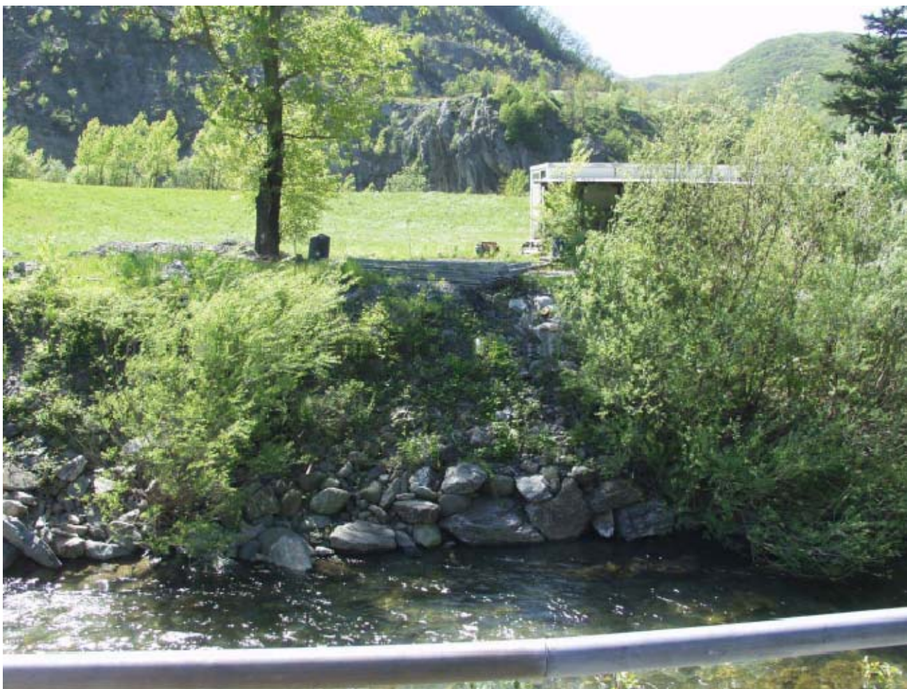
Fotografia n. 2 Difesa spondale con massi ciclopici sul lato orientale del CSP3
