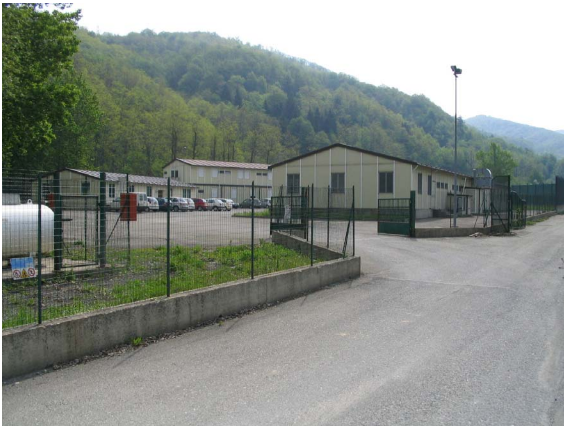
FOTO 3 – Cantiere CSP3 Val Lemme
