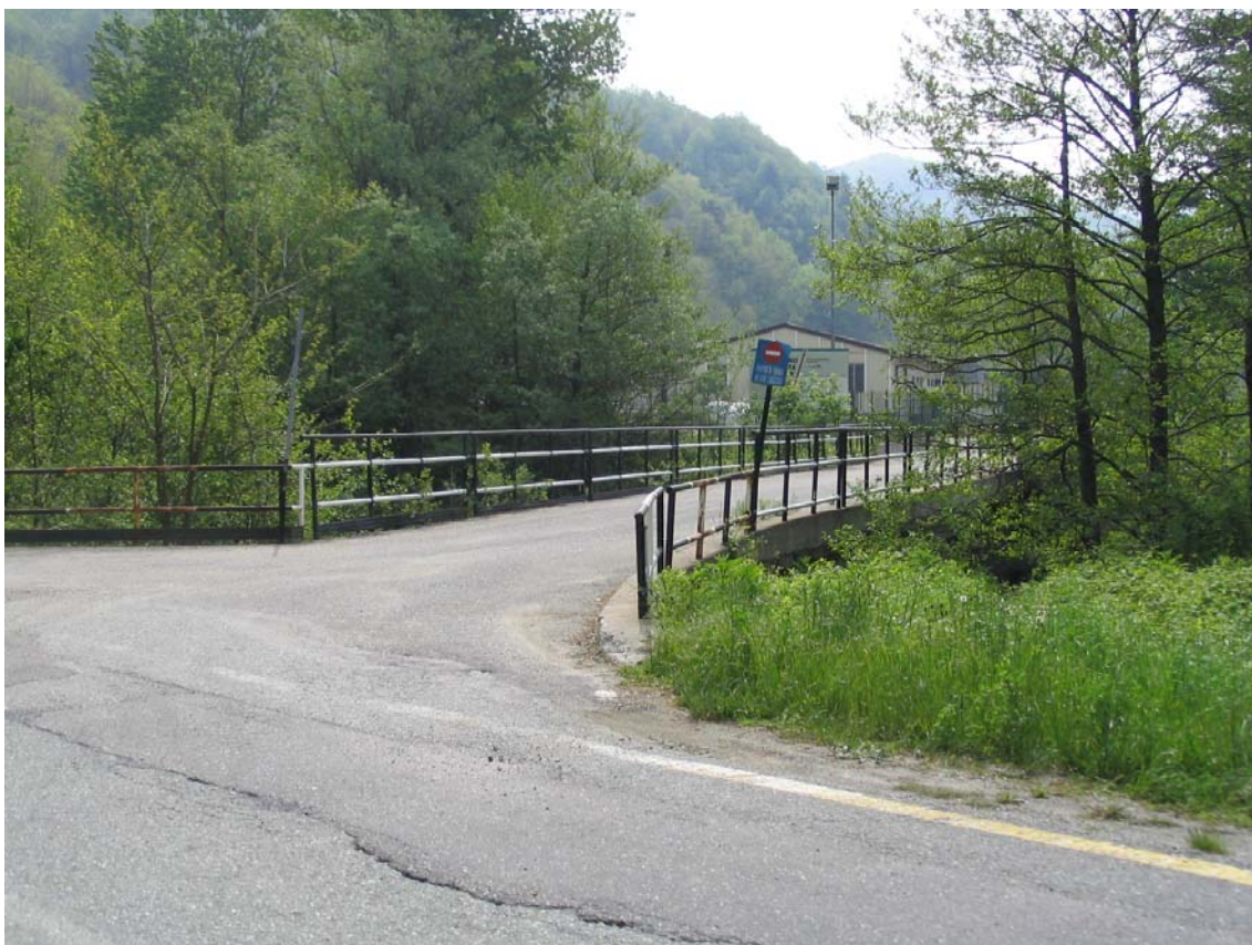
FOTO 1 – Cantiere CSP3 Val Lemme
