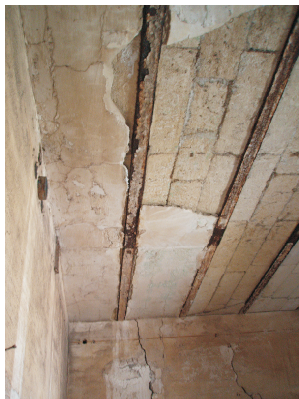
Torre Montello: stato di degrado dei solai
