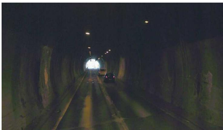
**Figura 12:** Galleria Renazza canna sud in cui sono chiaramente visibili lesioni sulla pavimentazione stradale e sul rivestimento definitivo della galleria.
