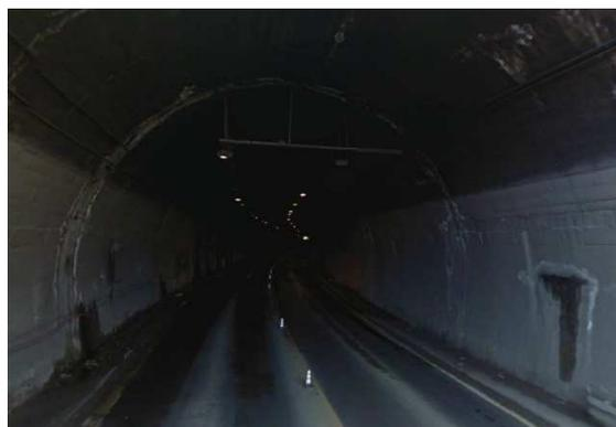
**Figura 17:** venute d'acqua lungo i piedritti della galleria e presenza di cedimenti del rivestimento definitivo.
