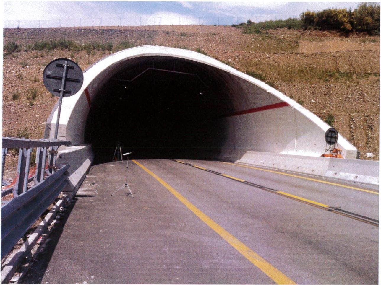
RILIEVO GALLERIA NATURALE 1 SUD A MT 3 DALL'IMBOCCO
