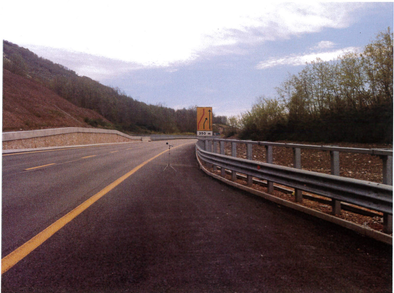
RILIEVO GALLERIA NATURALE 1 SUD A MT 150 DALL'IMBOCCO
