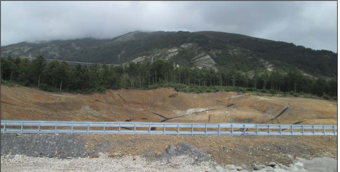
Figura 11: Sistemazione provvisoria per Esodo 2013, corpo stradale “CS36” su asse nord
