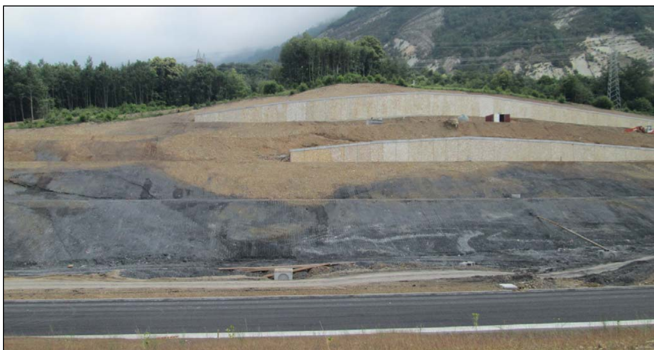
Figura 4: Panoramica della trincea nell'area Taggine – Proposta di Variante
