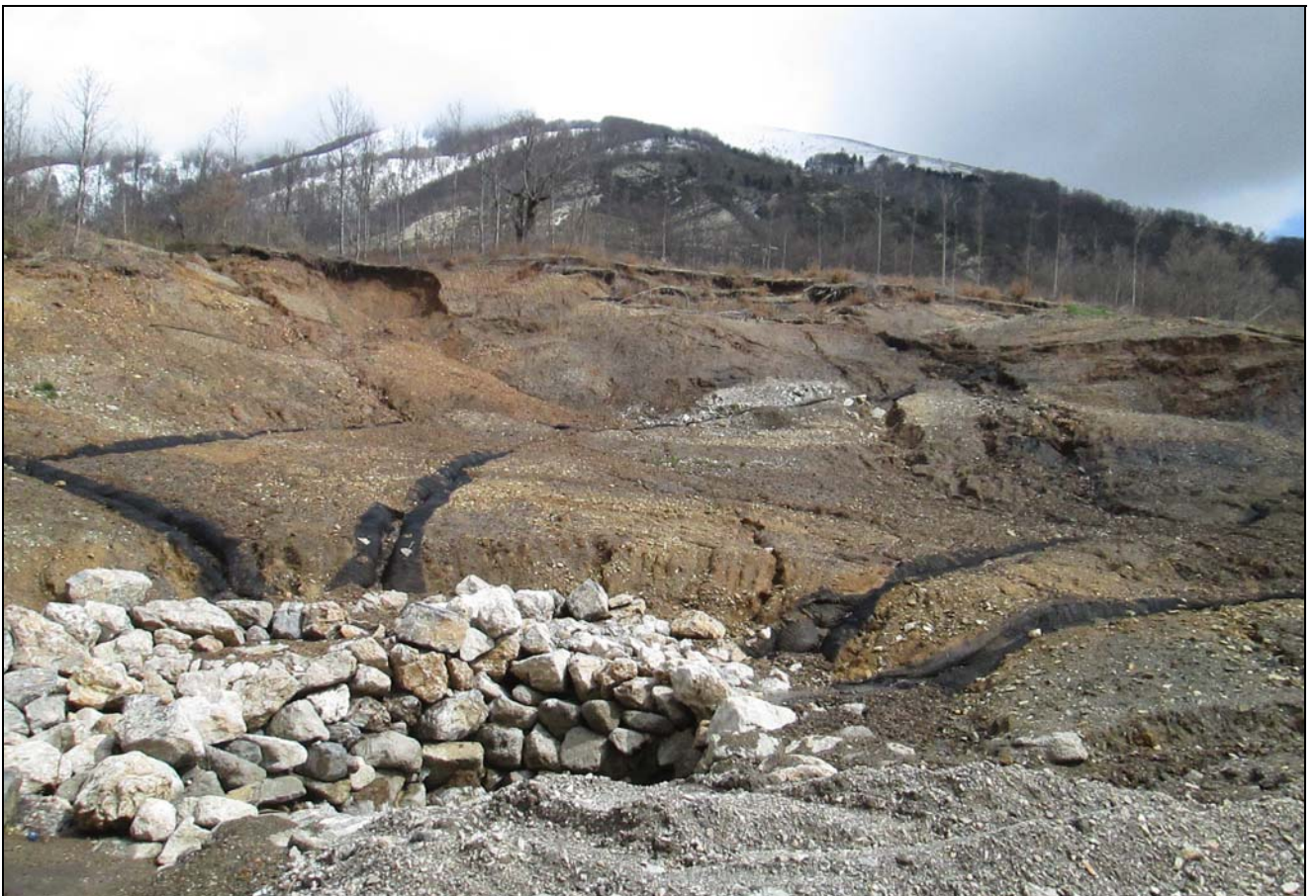
Figura 12: Riattivazione ed estensione dei fenomeni franosi dopo l’Esodo 2013, corpo stradale “CS36” su asse nord
