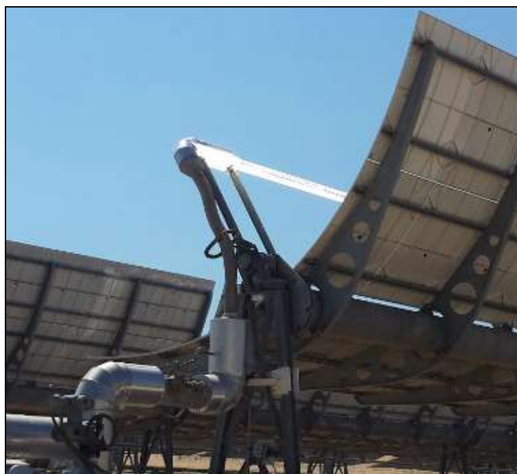
da Appendice 1 punto 4 - Figura 3: Esempio tubo flessibile per collegamento collettore-tubazione
