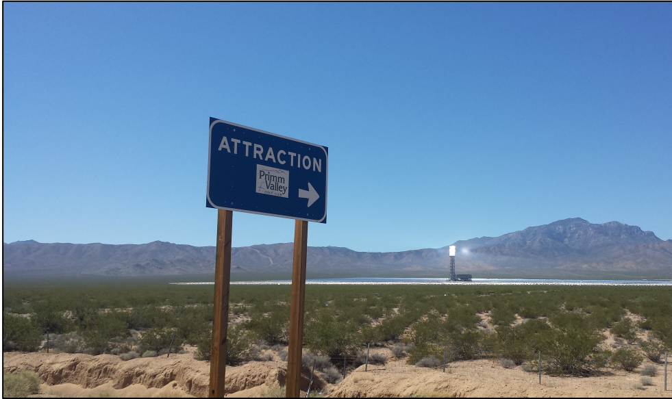
Figura 17: Impianto CSP a torre in California (USA)
