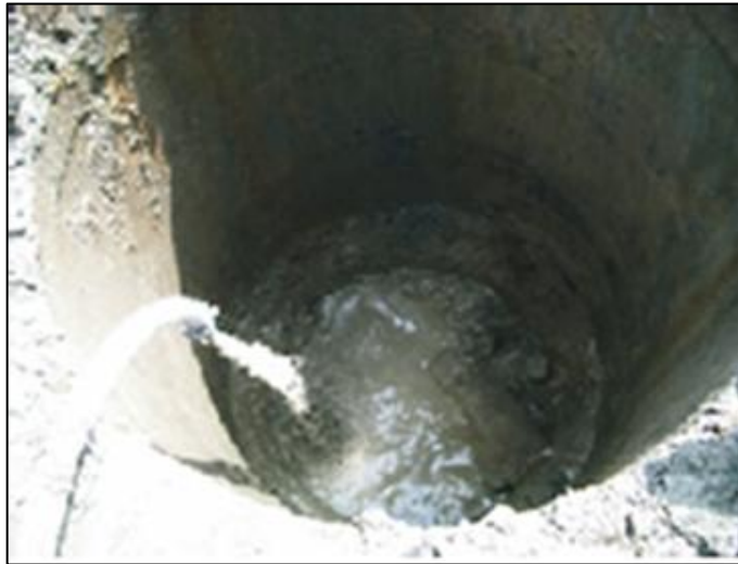
Figura 12: Inserimento nel foro di materiale di riempimento
