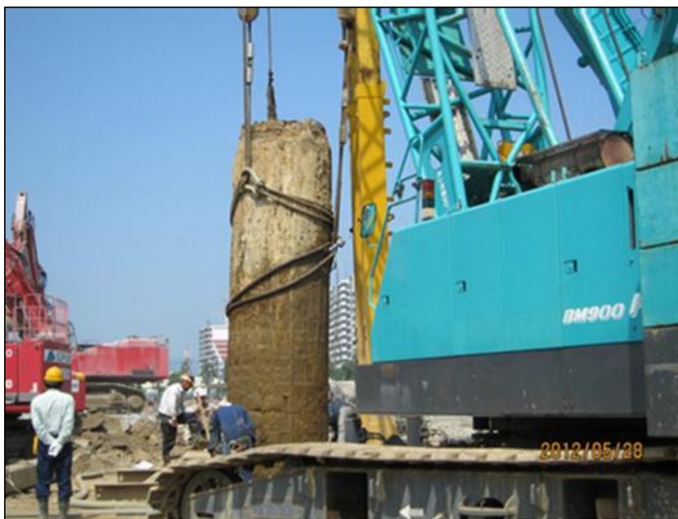
Figura 10: Sollevamento con gru dell'intera cassaforma
