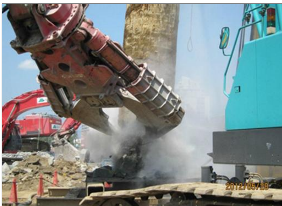
Figura 11: Riduzione della cassaforma in pezzi più piccoli per facilitare il successivo trattamento e trasporto
