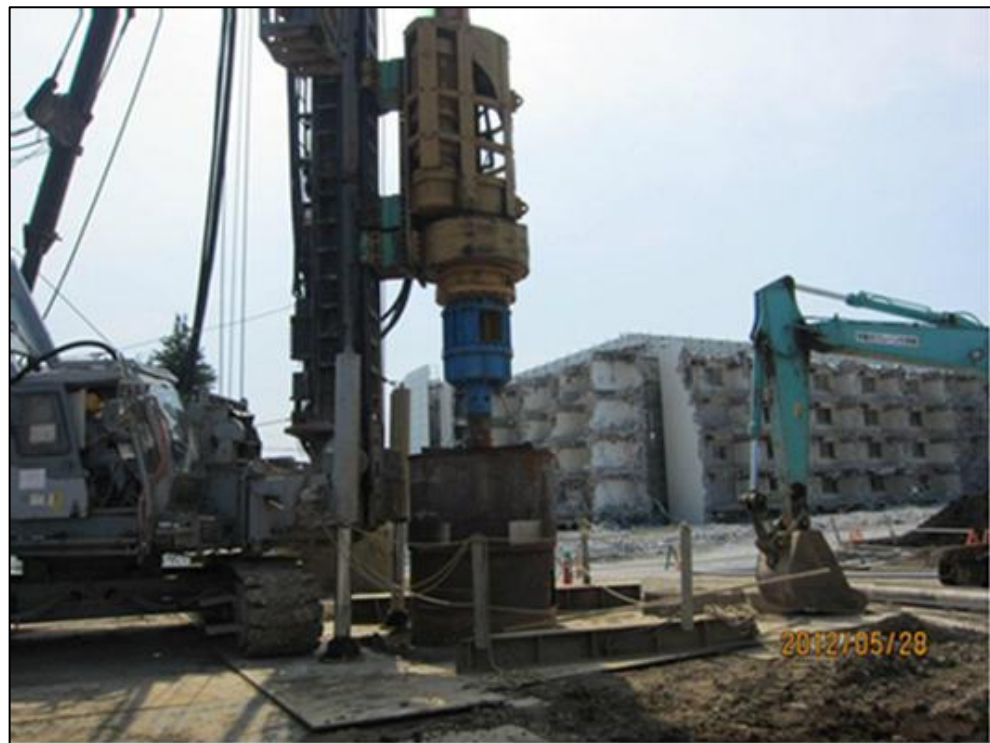
Figura 9: Trivella di perforazione e rivestimento intorno alla cassaforma esistente
