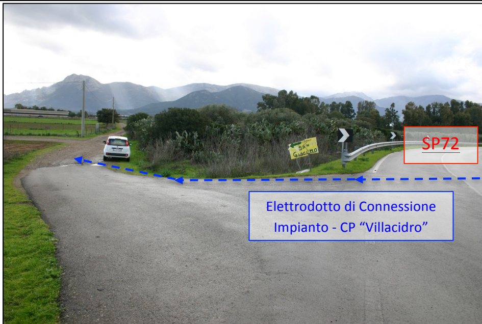
Figura 6: Elettrodotto di Connessione - Svolta su strada di collegamento fra la SP72 e la SP57
