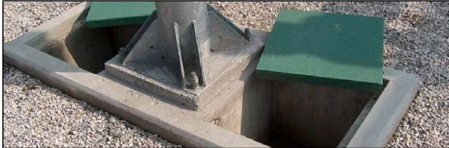
Figura 17: Esempio di copertura pozzetti con chiusini in PRFV
