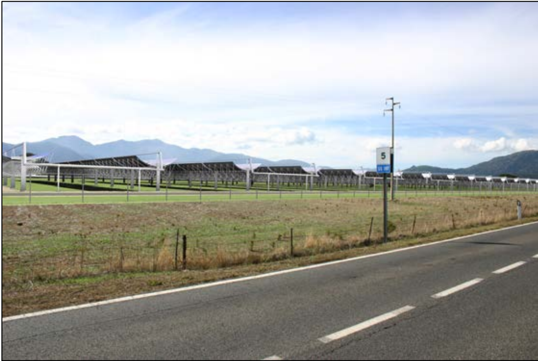
Figura 52: Punto di Vista 1 (PV1): Stato Modificato da strada SS197, collettori in posizione centrale
