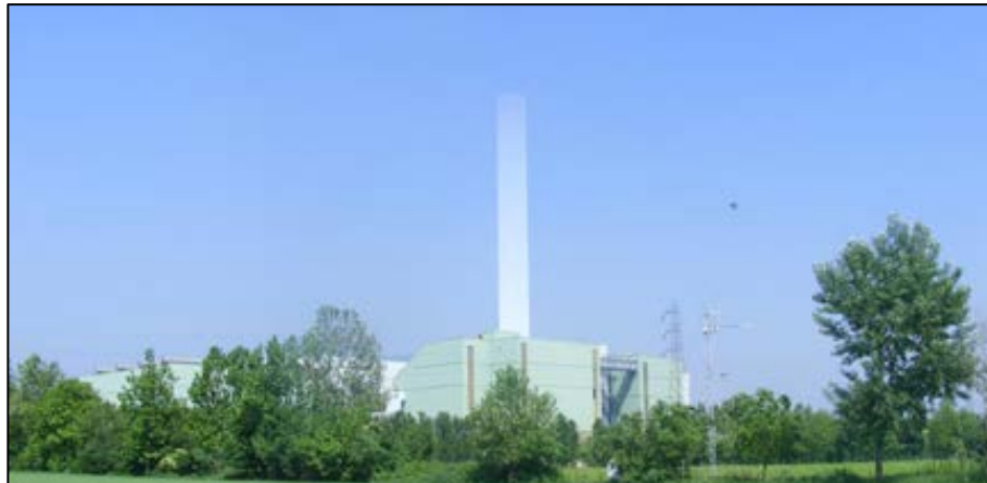
Figura 48: Camino Termovalorizzatore A2A di Brescia - Esempio colorazione strutture elevate
