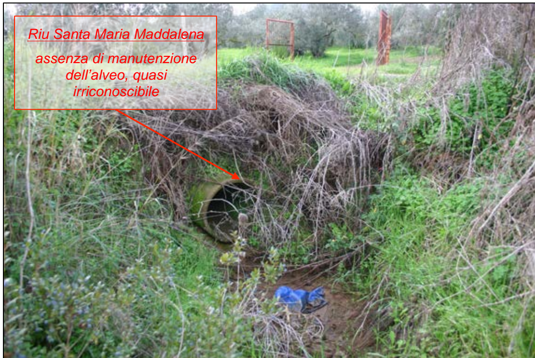
Figura 41: Presa fotografica punto PV12 - Riu Santa Maria Maddalena, tutelato ex art.143 D.Lgs 42/2004 (Sopralluogo Gennaio 2015)
