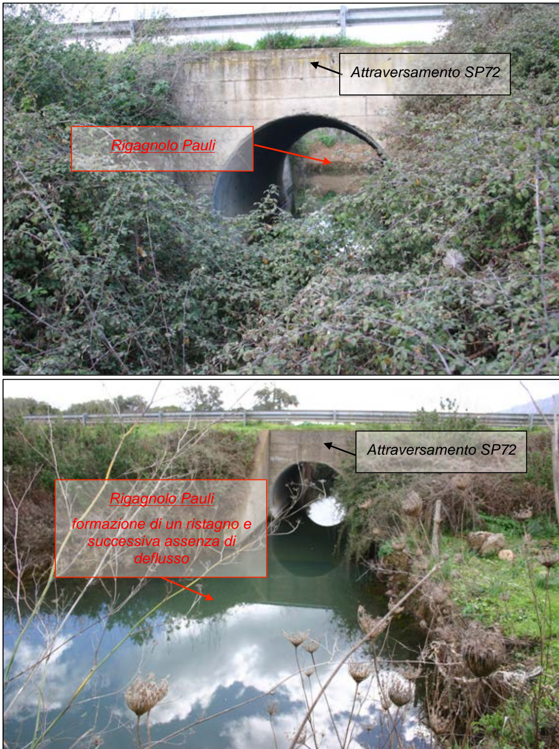
Figura 36: Presa fotografica punto PV7 - attraversamento SP72 (Sopralluogo Gennaio 2015)
