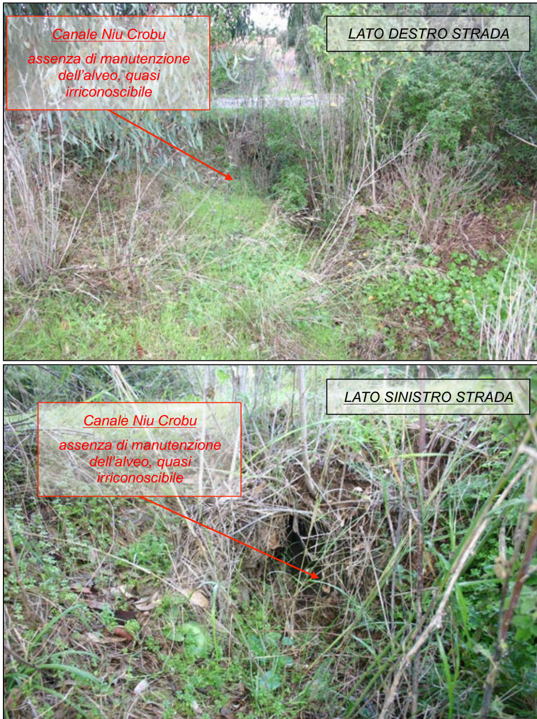
Figura 39: Presa fotografica punto PV10 - Canale Niu Crobu, tutelato ex art.143 D.Lgs 42/2004 (Sopralluogo Gennaio 2015)
