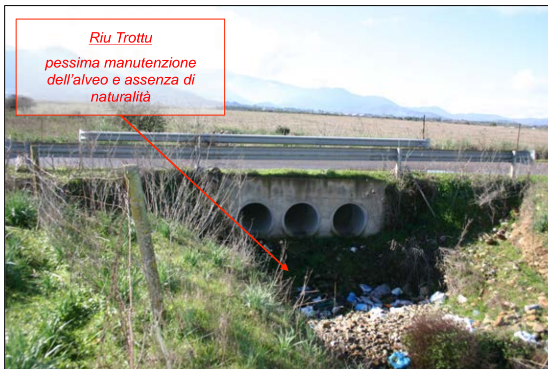
Figura 37: Presa fotografica punto PV8 - Riu Trottu, tutelato ex art.143 D.Lgs 42/2004 (Sopralluogo Gennaio 2015)
