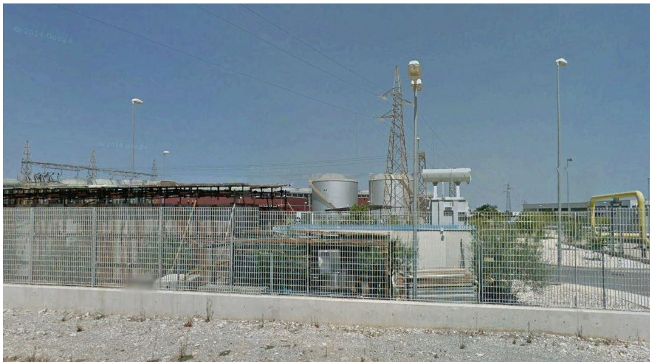
Foto rappresentativa del sostegno in area per la produzione e distribuzione dell'energia (sostegno 112)
