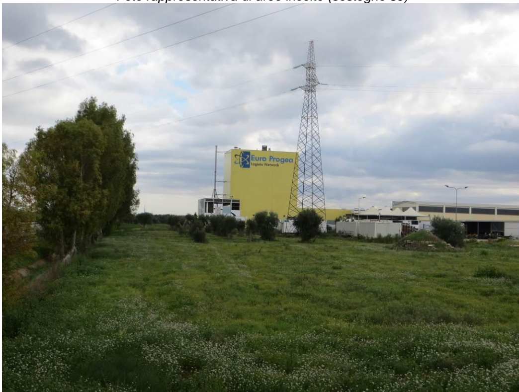
Foto rappresentativa del sostegno in insediamento industriale o artigianale con spazi annessi (sostegno 111)
