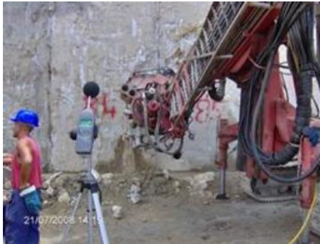
Figura 221 – Jet-grouting, impianti pompe e compressori - L_w dB(A)/m = 93.4
