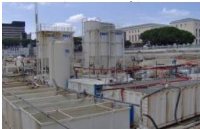
Figura 222 – Impianto di betonaggio e preconfezionamento calcestruzzi (fonte: Calcestruzzi Spa) - L_w dB(A)/m = 79.7
