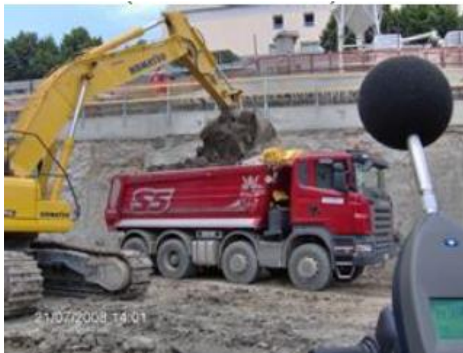
Figura 218 – Operazioni di movimentazione materiali e terre nelle aree di cantiere - Livello di potenza a 5 mt dalla sorgente - L_w dB(A)/m = 79.7
