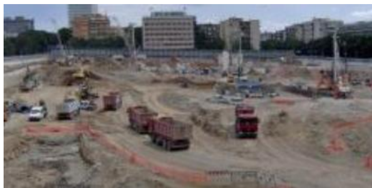
Figura 219 – Installazioni cantiere, officina, lavorazioni di carpenteria metallica leggera, riparazioni idrauliche, riparazione delle attrezzature - L_w dB(A)/m = 66.9
