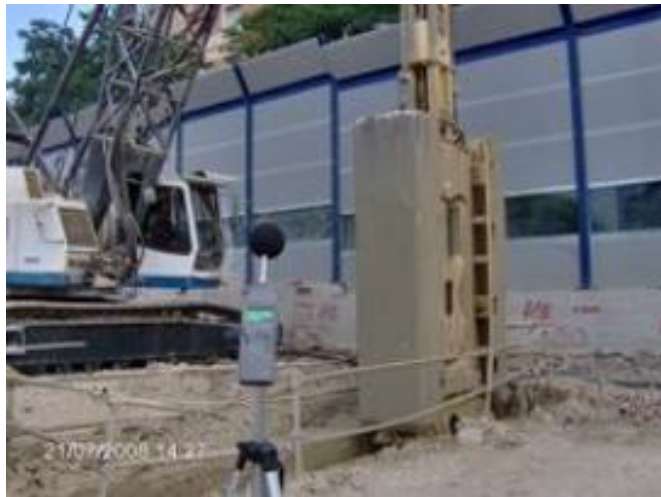
Figura 220 –Realizzazione di diaframmi, realizzazione di pali trivellati (fonte: Università degli Studi di Ferrara - Fausti) - L_w dB(A)/m = 93.4
