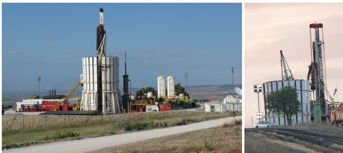
Figura 4.10: Impianto di perforazione HH 220 Leonardo (fase di workover su TT20)
