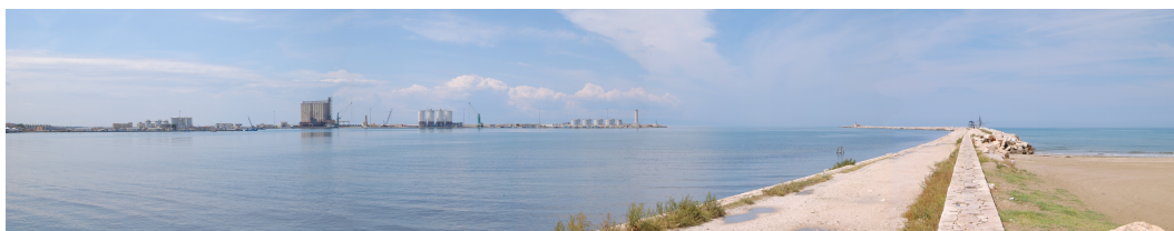
Figura 5.6 – Punto di ripresa n. 2 – Molo di Barletta, vista in direzione Nord Ovest – Foto simulazione.
