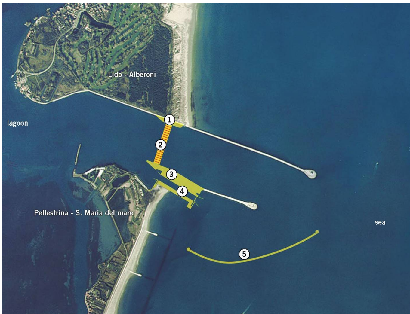
Figura 22-10 Configurazione della bocca di porto di Malamocco con le opere del MOSE (Fonte: Consorzio Venezia Nuova, 2013. Quaderni Trimestrali, 1.13).
