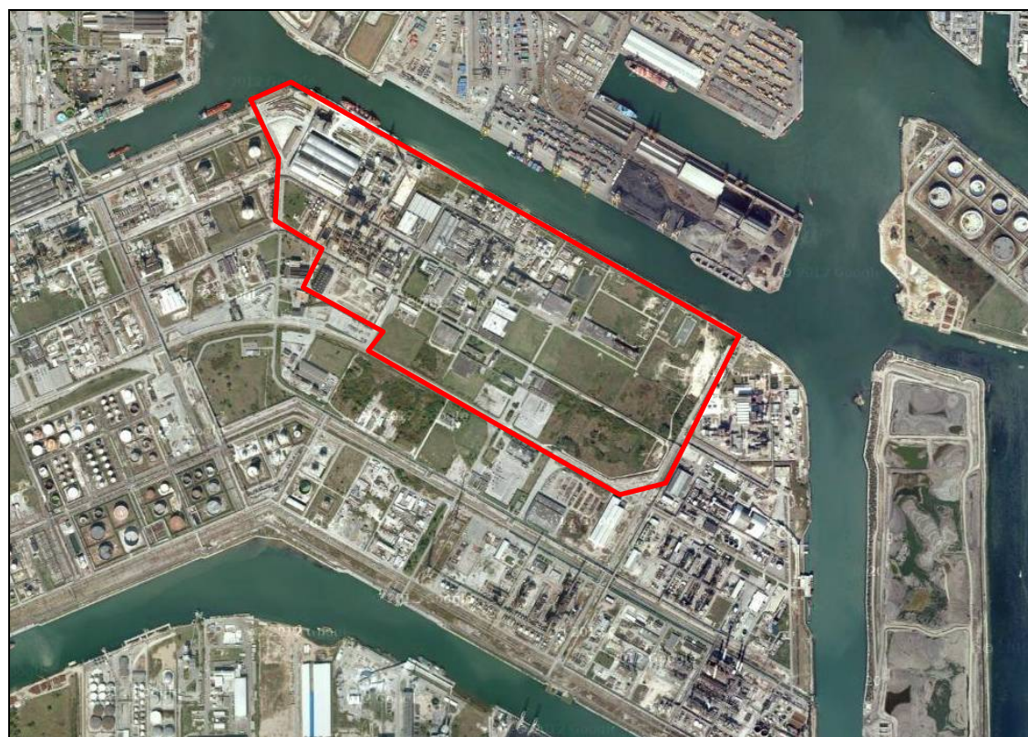
Figura 45-16 - Inquadramento ortofotografico dell'area allo stato di fatto (fonte Google Maps).
