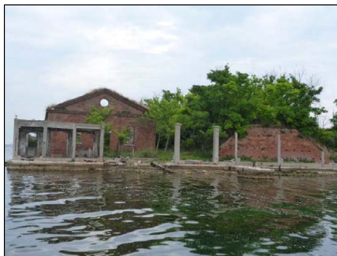
Figura 8. Sant'Angelo delle Polveri: particolare dell'edificio
