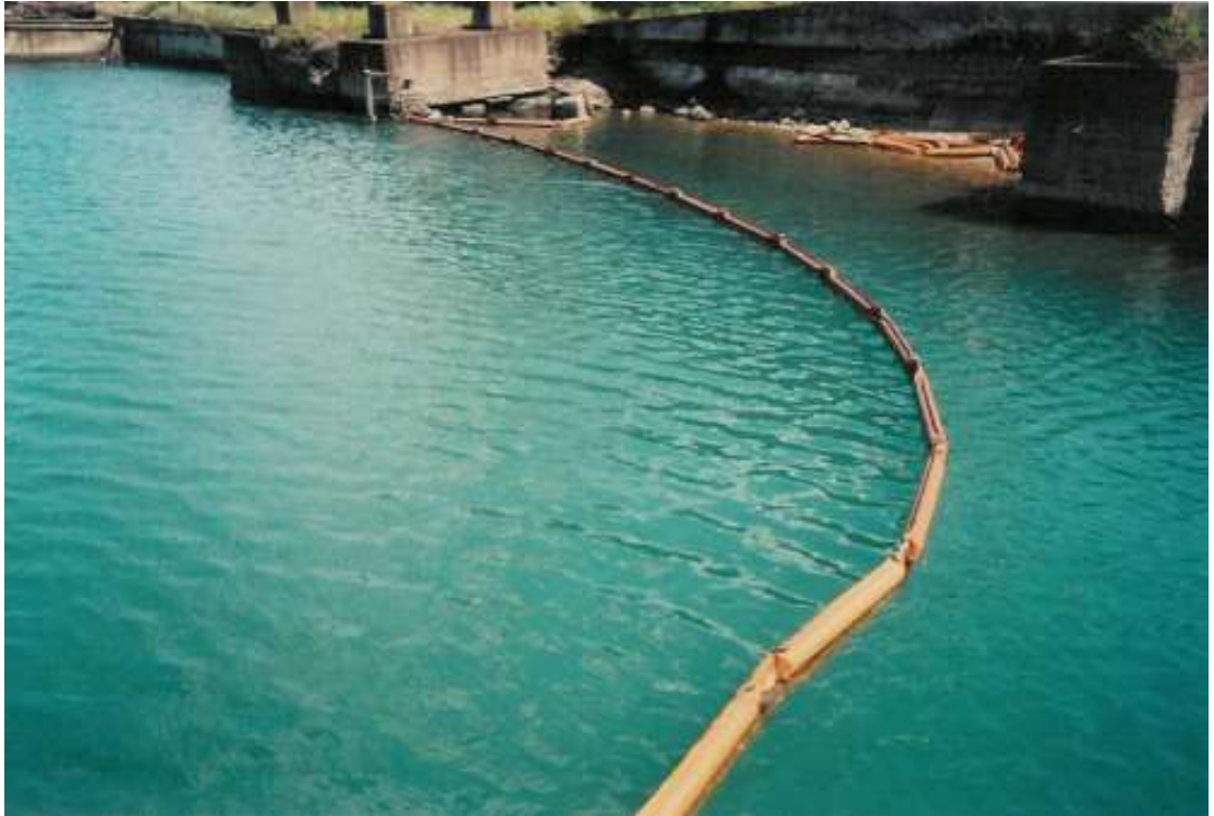
Figura 3-14 Confinamento area di scavo con panne mobili.
