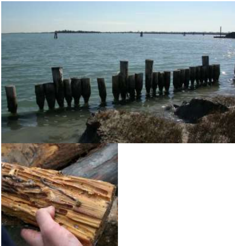
Figura 2-2 Palificata degradata dall'azione delle teredini, che perforano e penetrano in senso longitudinale all'interno del palo (MAGISTRATO ALLE ACQUE - CVN-SI, 2008).
