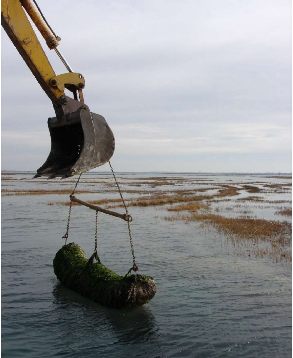
Figura 2-5 Operazione di rimozione delle burghe lungo il canale di Burano (MAGISTRATO ALLE ACQUE- CVN-SI, 2008).
