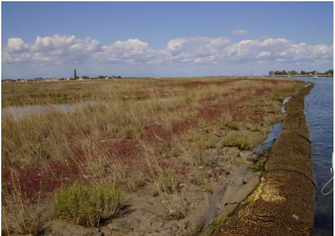
Figura 2-4 Barena Ca la Vela: conterminazione in burghe (MAGISTRATO ALLE ACQUE - CVN-SI, 2008).
