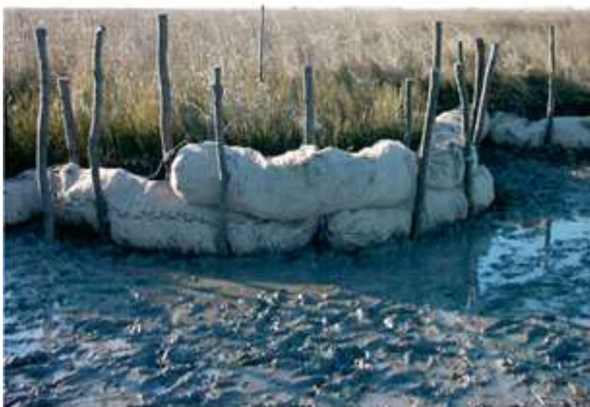
Figura 2-6 Buzzoni in cocco ai margini della canaletta Laghi (sopra). Buzzoni con ramaglie (sotto), al momento della realizzazione 2001. Fonte MAGISTRATO ALLE ACQUE - CVN-SI, 2008.
