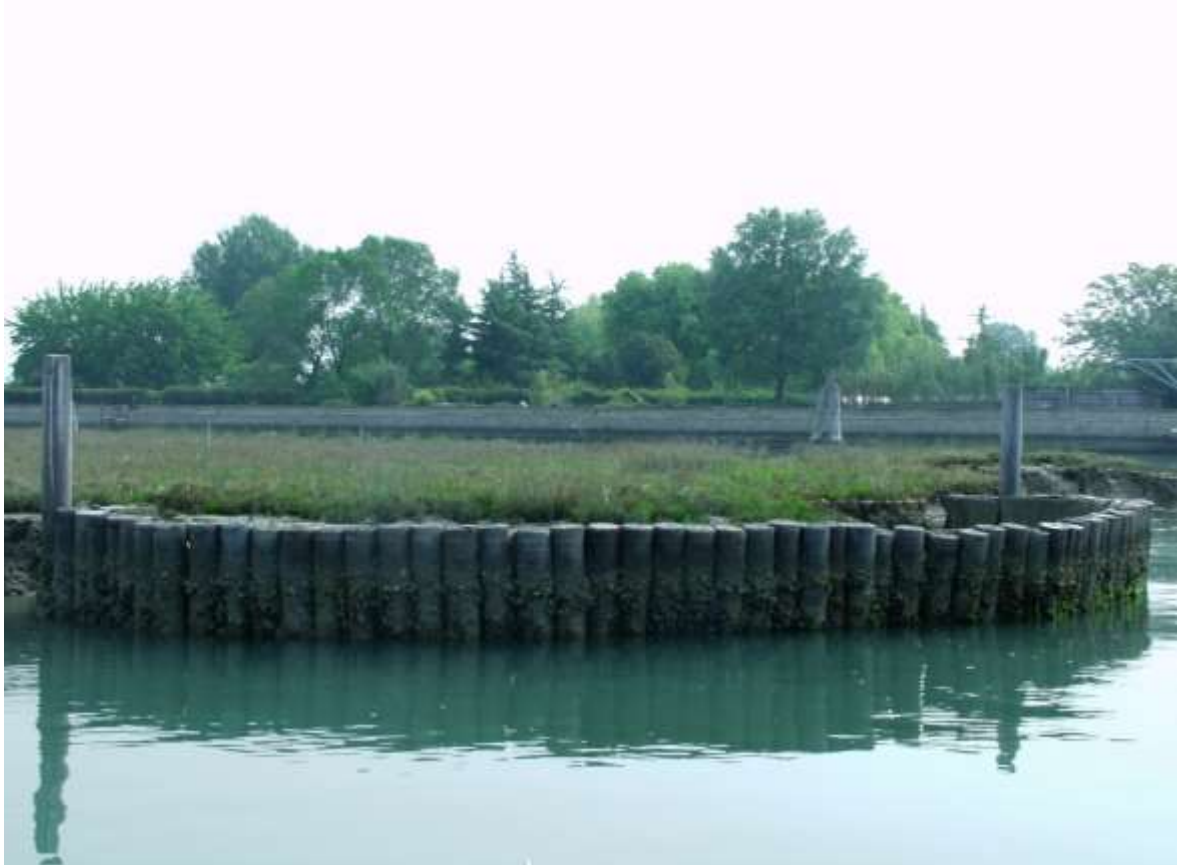
Figura 2-3 Pali in plastica a protezione di un tratto di margine della barena naturale Tresso a 5 anni dall'infissione (MAGISTRATO ALLE ACQUE - CVN-SI, 2008).
