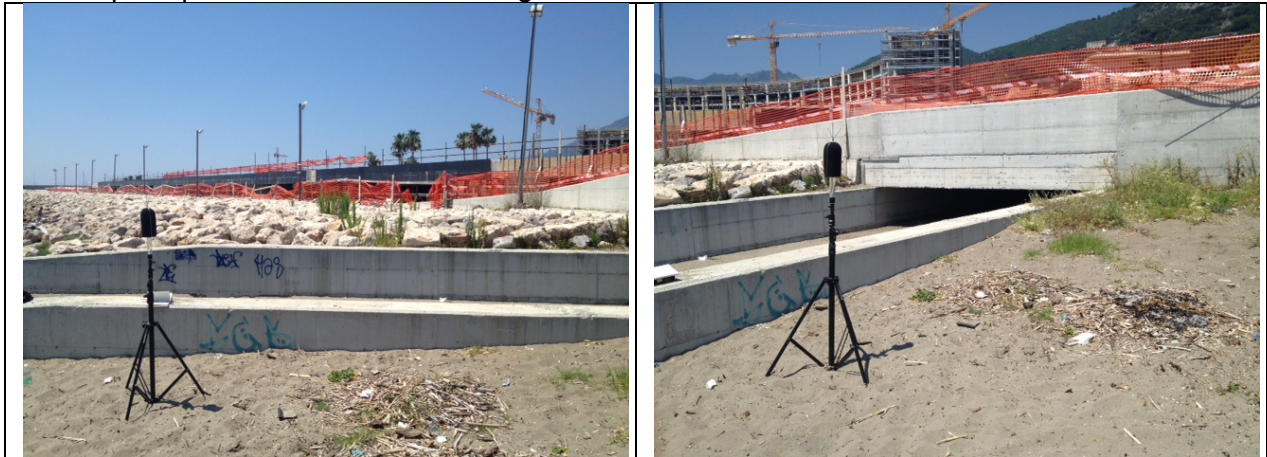
Figura 5.7 – Posizionamento della strumentazione impiegata nel punto R05 (campagna di giugno)
